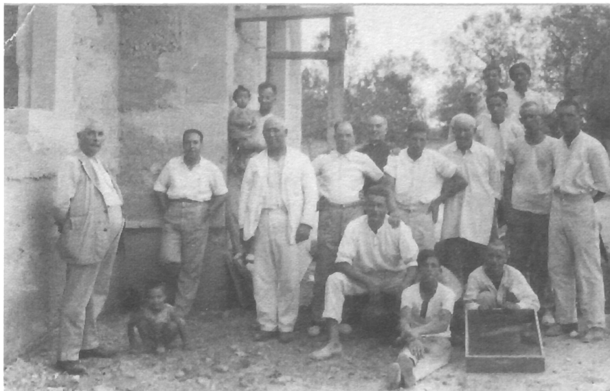
Obres de construcció de l'Escola Graduada de Sencelles, 1933: és una imatge que mostra un descans dels picapedrers que construïen la nova Escola Graduada de Sencelles perquè reberen la visita d'autoritats locals republicanes. Llorenç Duran és la segona persona, començant per mà esquerra. Té les mans dins les butxaques i està recolzat a la paret
