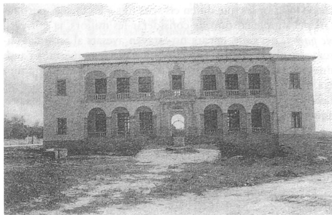
L'escola graduada, tot just després d'haver finalitzat les obres
