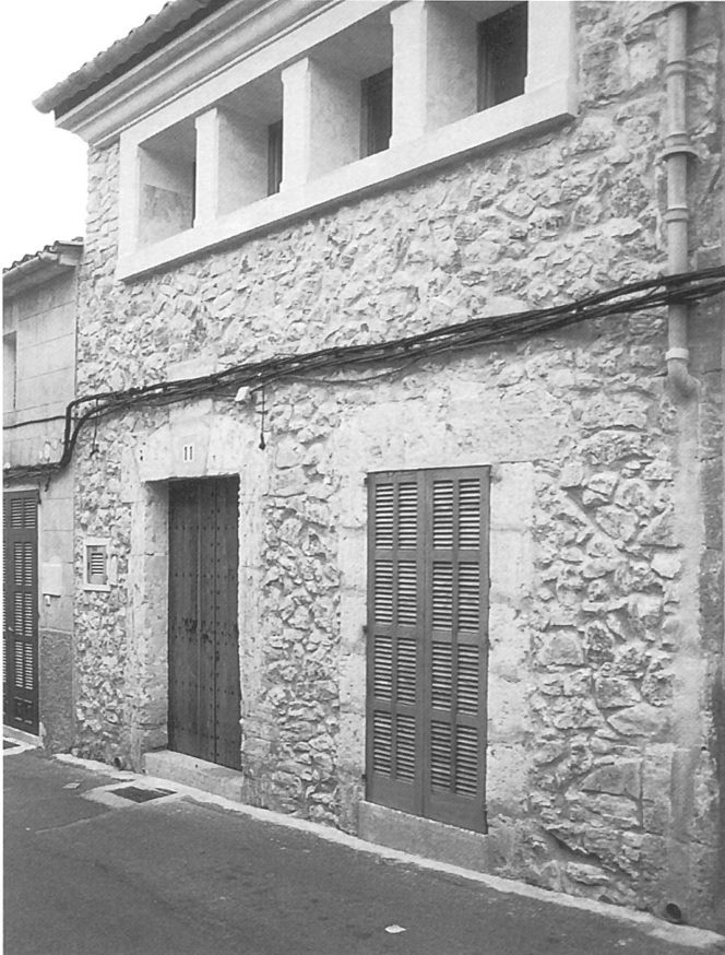
Fotografia núm. 2. Casa del carrer de la Rutla, de Petra: abans de la rehabilitació, a la façana només hi havia el portal, una finestra a la planta baixa i un finestró just damunt el portal. Aquí han fet alçar la casa sense respectar gens les finestres.
