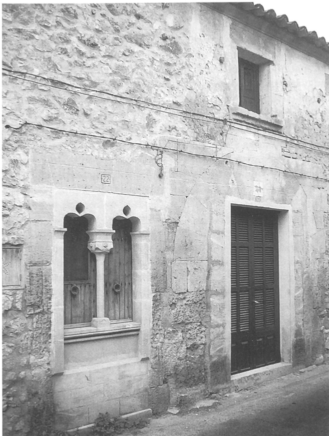
Fotografia núm. 3. Casa del carrer del Barracar Baix, de Petra: hi podem observar una variant de finestra coronella o geminada, afegida amb la rehabilitació recent de la casa, que no segueix gens els models tradicionals populars.
