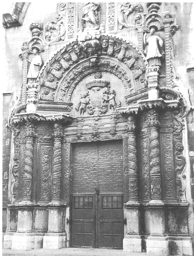
Portal de l'església de Montí-Sion
