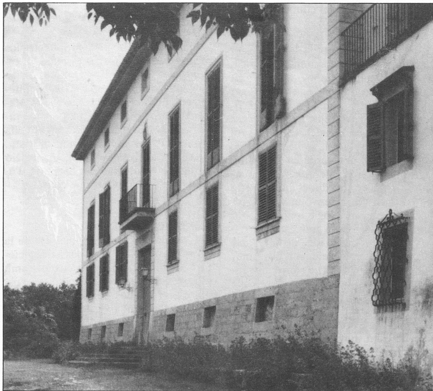
El casal de Canet exigeix una observació acurada, tant visual com informativa, si es vol entendre el noble missatge arquitectònic que expressa l'edifici (Foto de l'autor)
