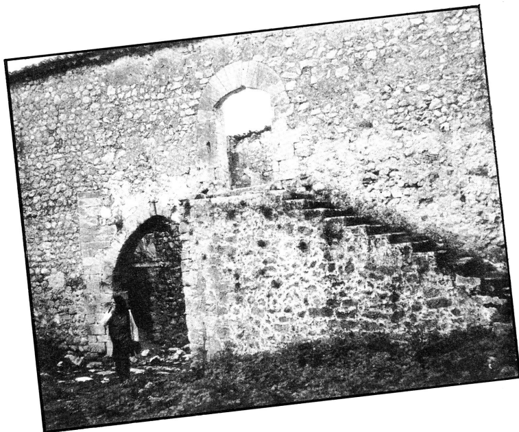
Façana de la clastra de Son Catlar de Mancor, segons una fotografia presa el mateix any de la seva destrucció: 1982. (Foto Jaume Llabrés).
