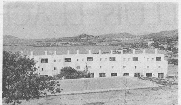
Part posterior d'un grup d'apartaments, a la urbanització «dels arquitectes», amb Talamanca i la ciutat d'Eivissa al fons.
