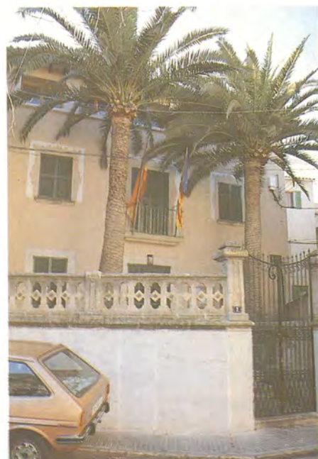
↓ Edifici de l'Ajuntament de Bunyola
