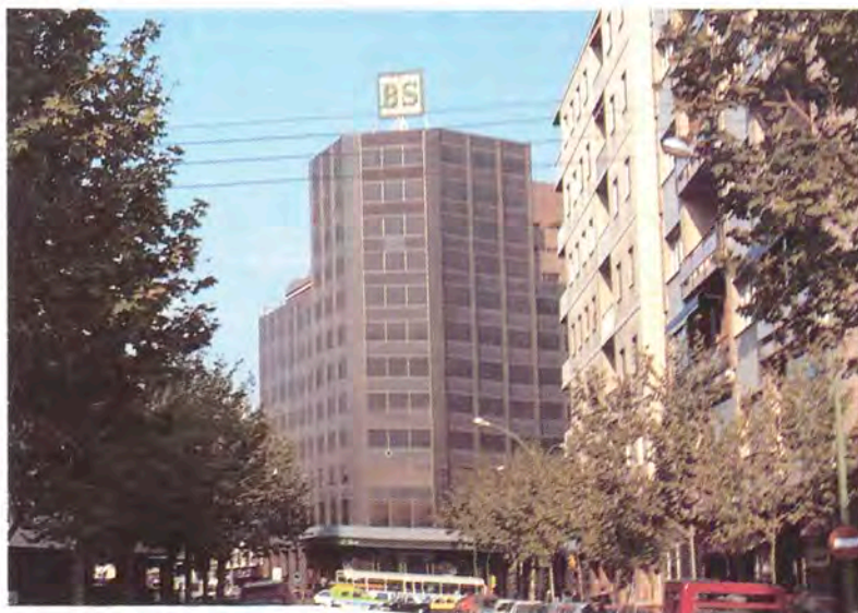
→ Edifici de l'oficina central del Banc de Santander a Palma
