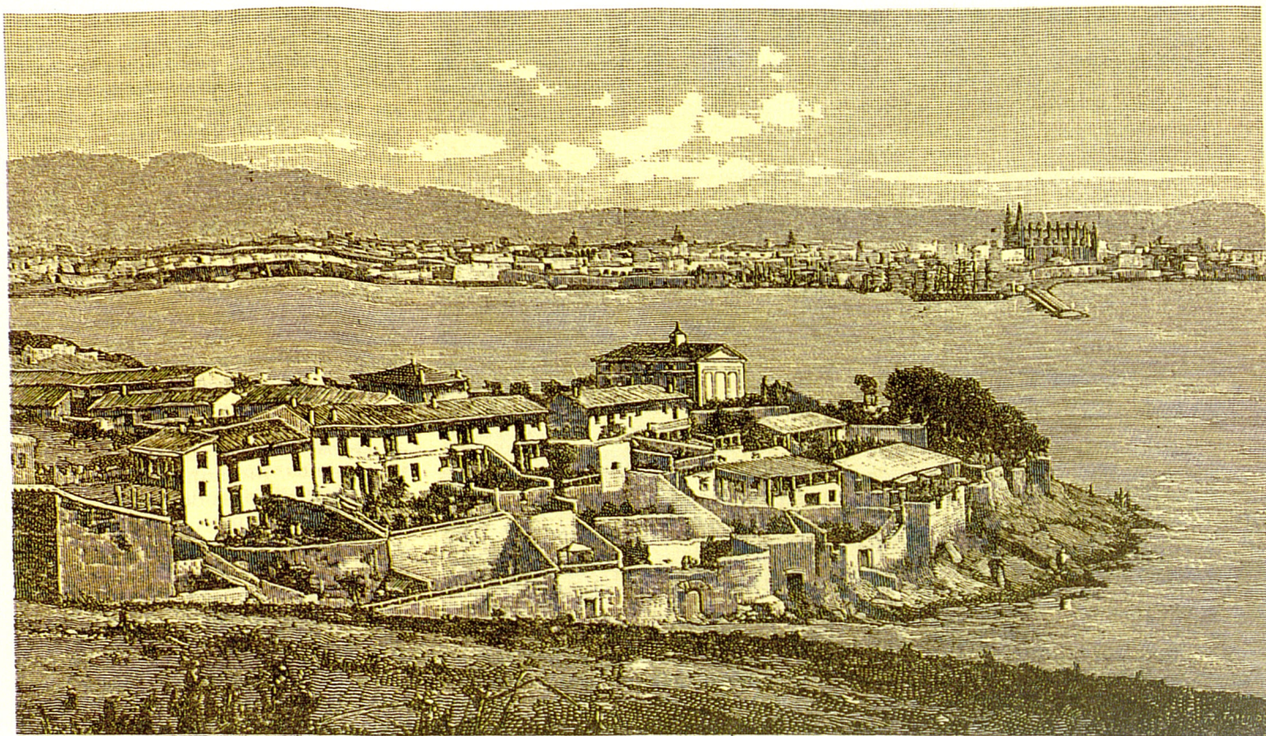
↑ Gravats del port de Palma, amb la Institució Natzaret al centre
