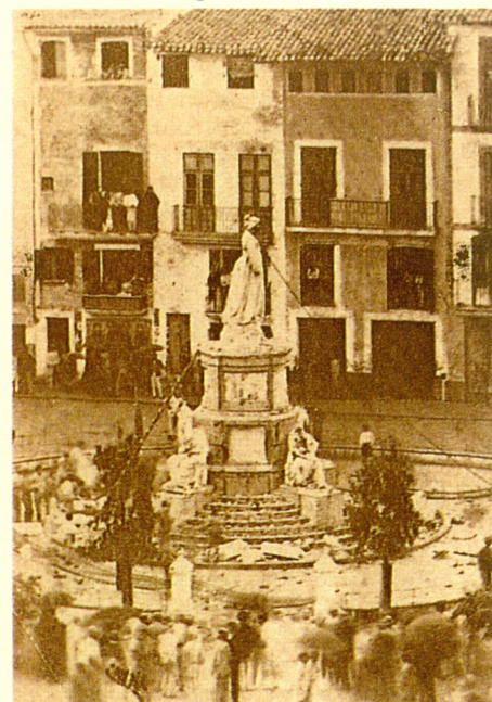
↓ Demolició del monument a Isabel II
