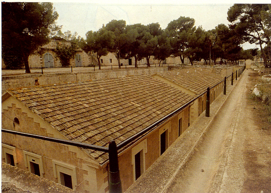
↑ Fort d'Illetes (Calvià), recinte interior amb els barracons per a la tropa en primer pla
