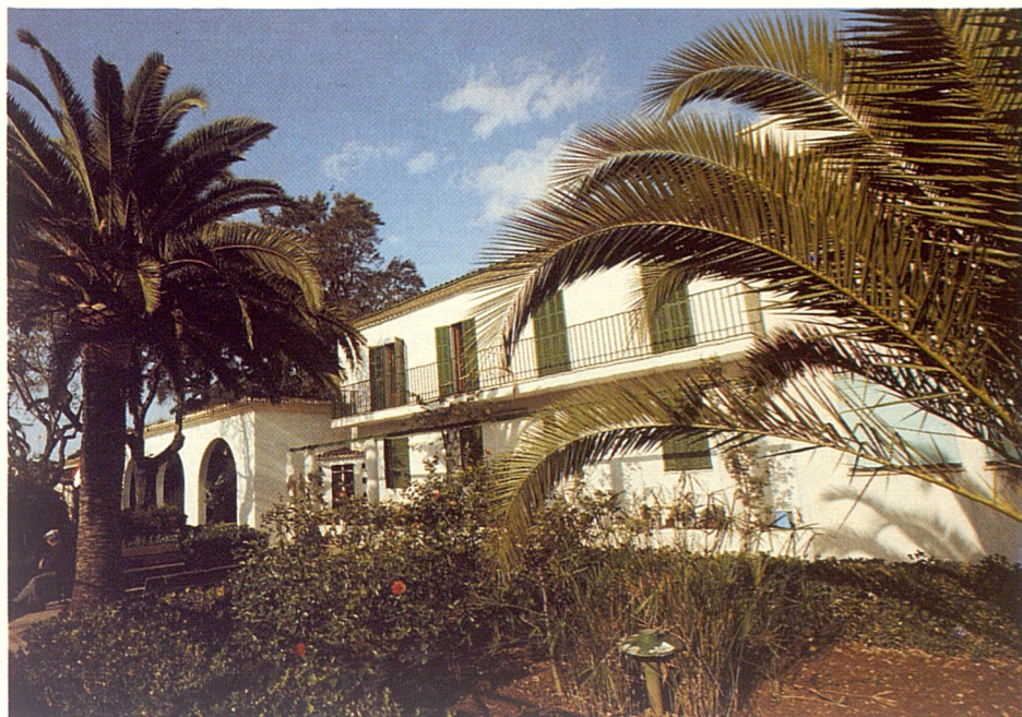
↑ Façana principal de l'Hospital de Manacor
