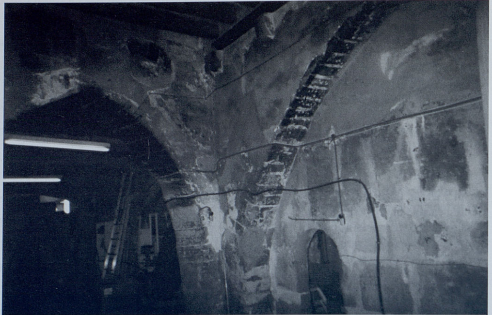
Els arcs apuntats gòtics amb permòdols de cap de biga d'una antiga gerreria que hi havia al carrer d'en Bauló (les mènsules de pedra que aguanten una biga de fusta adossada a la part superior de l'arc). Fèrem la fotografia l'any 2003. Gairebé tot s'esbucà aquest agost passat; només les dovelles dels arcs se n'han salvat per ara.
