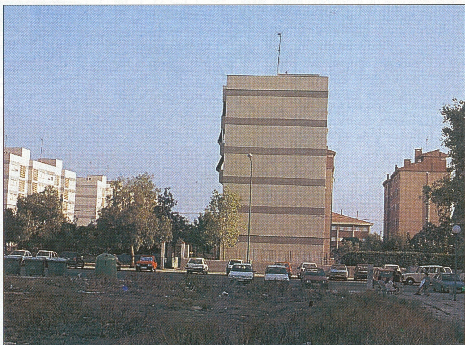
Habitatges de la Soledat Sud
