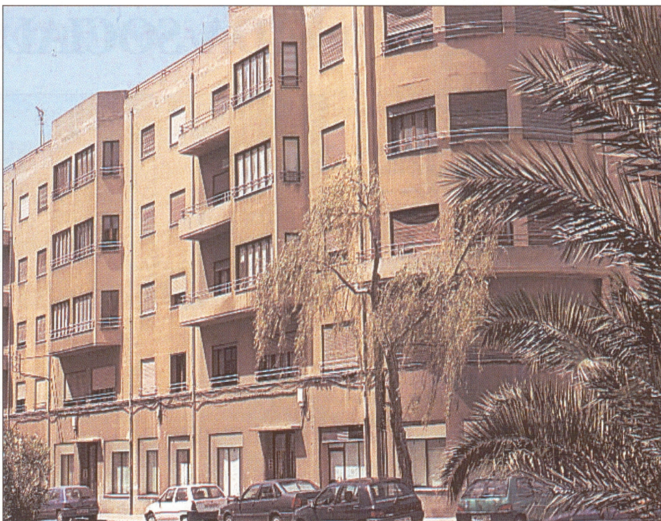
Casa de pisos de can Domenge, al carrer del General Riera
