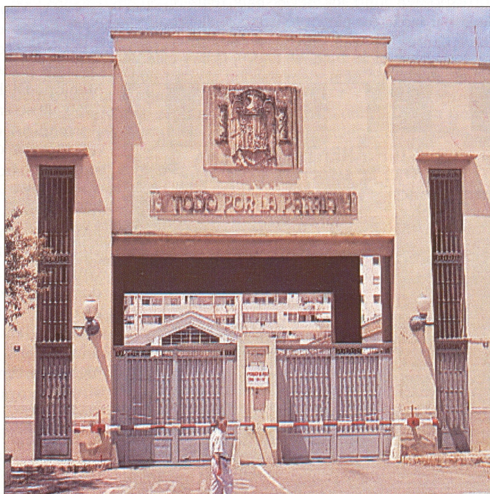
Quarter d'Automòbils, al carrer de l'Arquitecte Forteza
