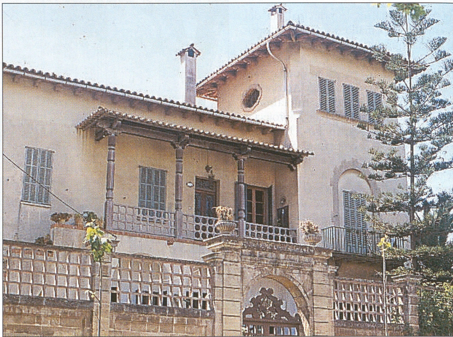
Casa del carrer Alferez Cerdà, 3
