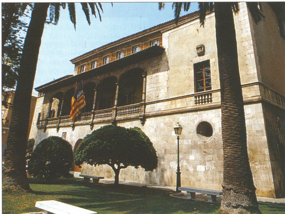
Consolat de la Mar
