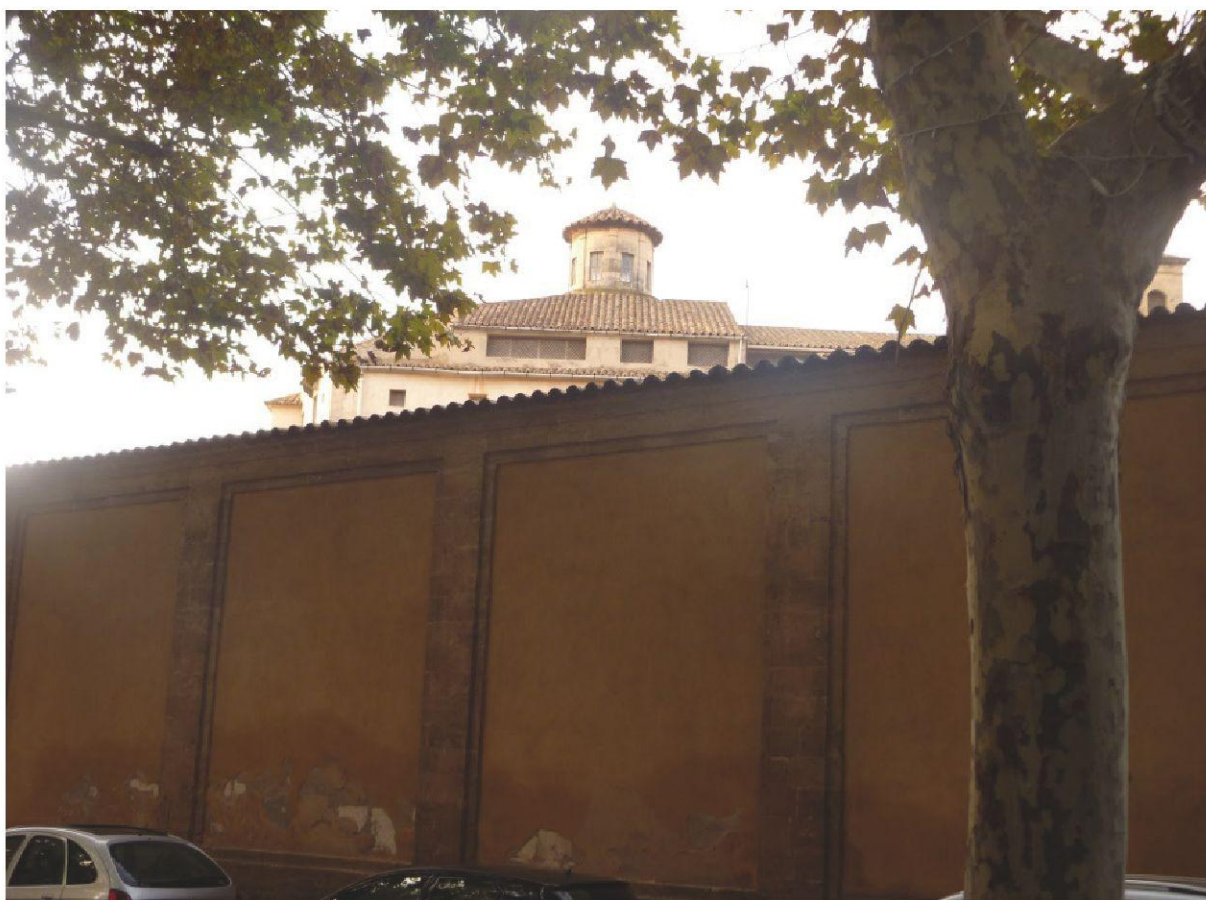
Fig. 5. Muro del convento de Santa Magdalena. Fuente: elaboración propia.
