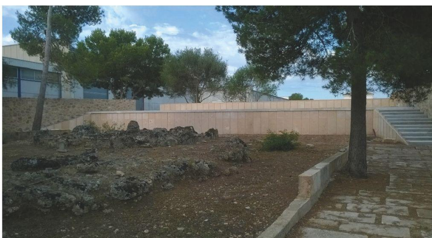
Estat actual de les obres de condicionament del sepulcre de Son Bauló.
