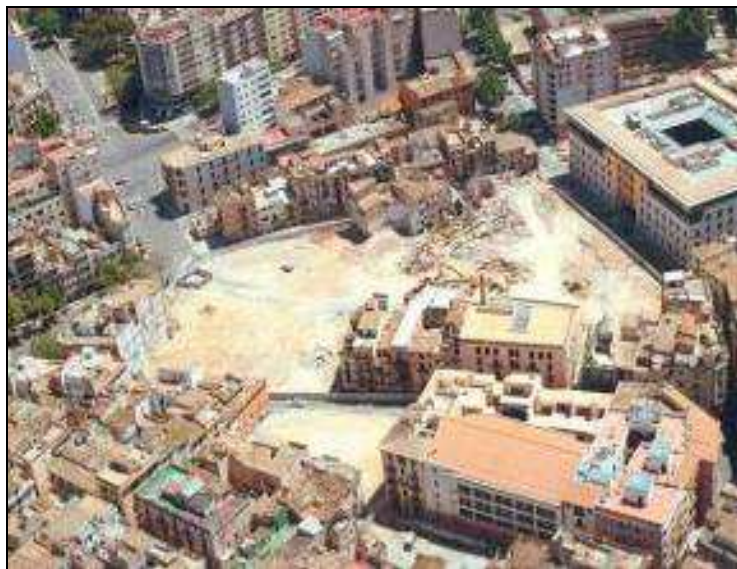
Figura 236: demolició de la Unitat d'Execució 2B
