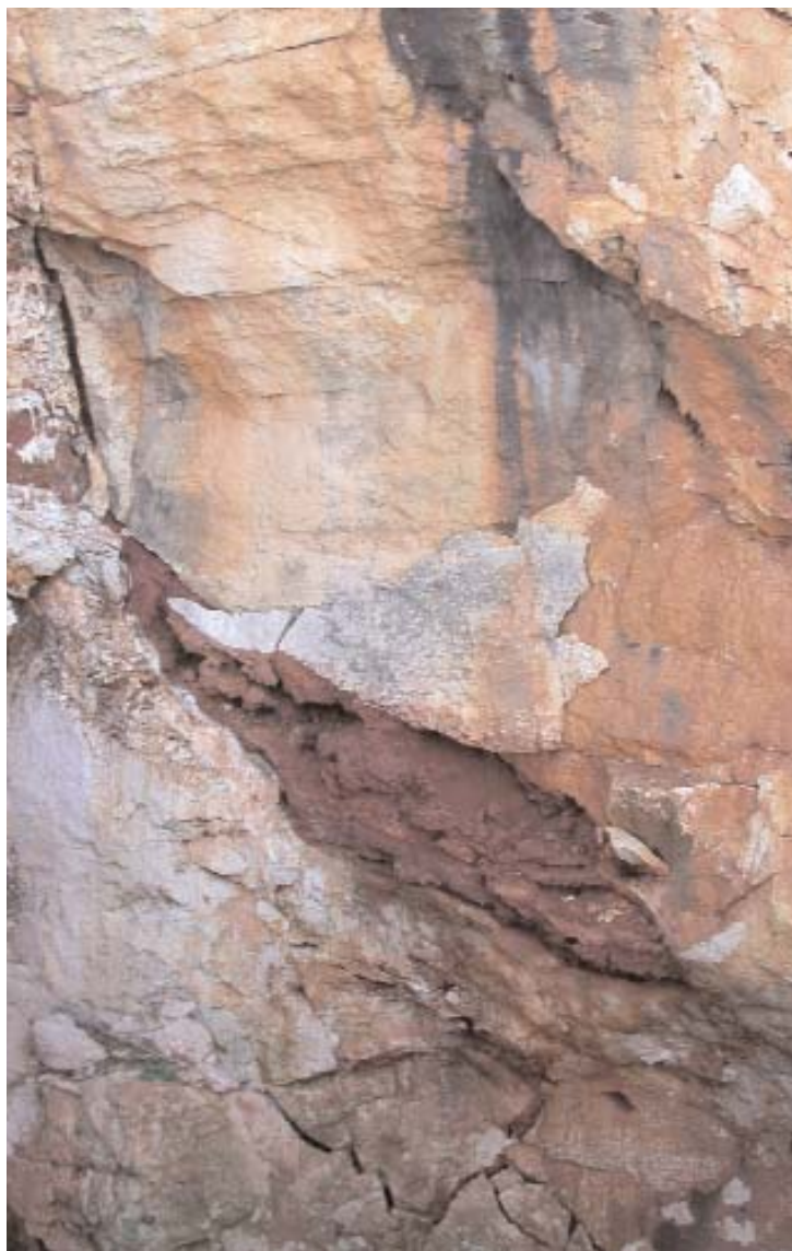
Figura 80. Detalle de una fractura rellena, con marcas de disolución
