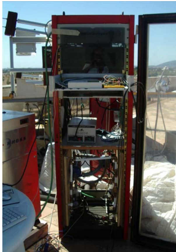
Figura 7.13: Equipos de medida. Banco de ensayos en el exterior
