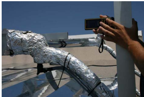
Figura 7.42: Medición de la posición relativa horizontal entre tubos receptores extremos y las vigas soporte de los reflectores
