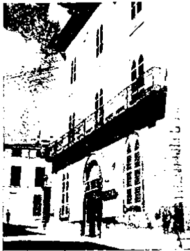
FACHADA DEL EDIFICIO DONDE ESTÁ EL MUSEO
