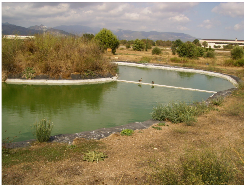
Figura 3.8. Llacuna de maduració del sistema de depuració per llacunatge del campus de la Universitat de les Illes Balears.
