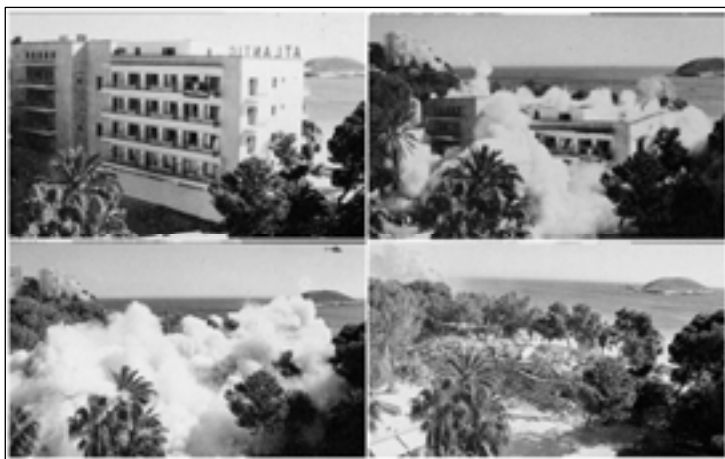
Figura 7. Demolició de l'Hotel Atlantic (Calvià, 1996).
