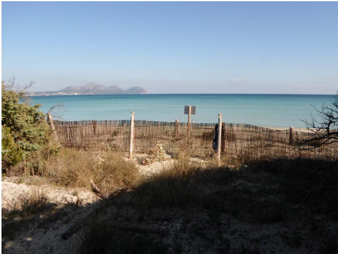
Figura 200: Trampa d'interferència sedimentària a la boca del blowout , paral·lela a la línia de costa. Foto del 14/11/2013.
