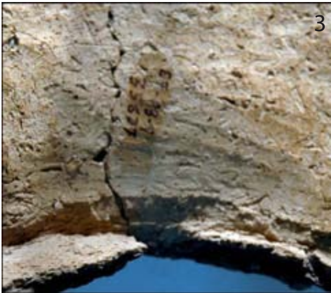
Acanaladuras generadas durante el compactado
