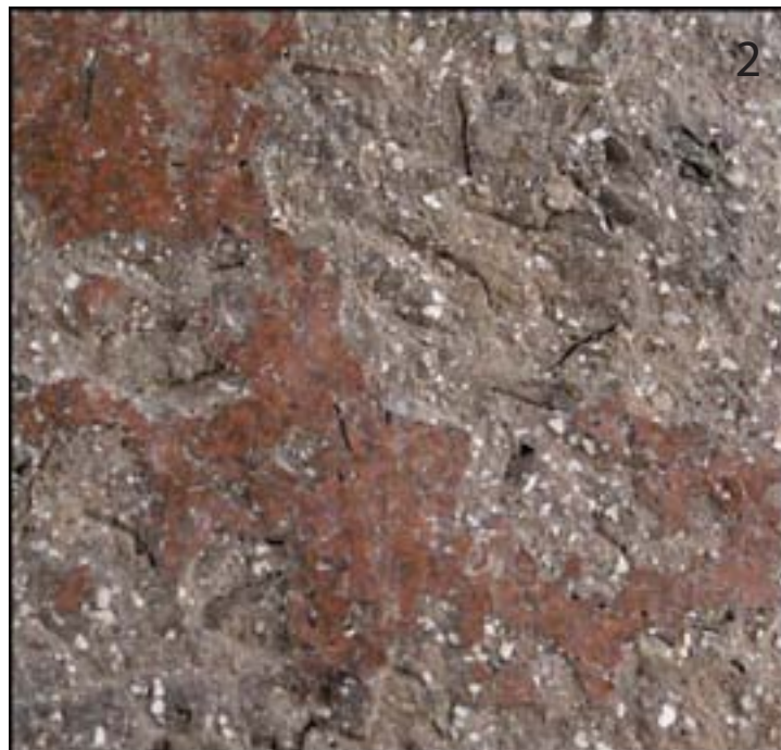
Láminas superpuestas que indican la aplicación de una capa de engobe
