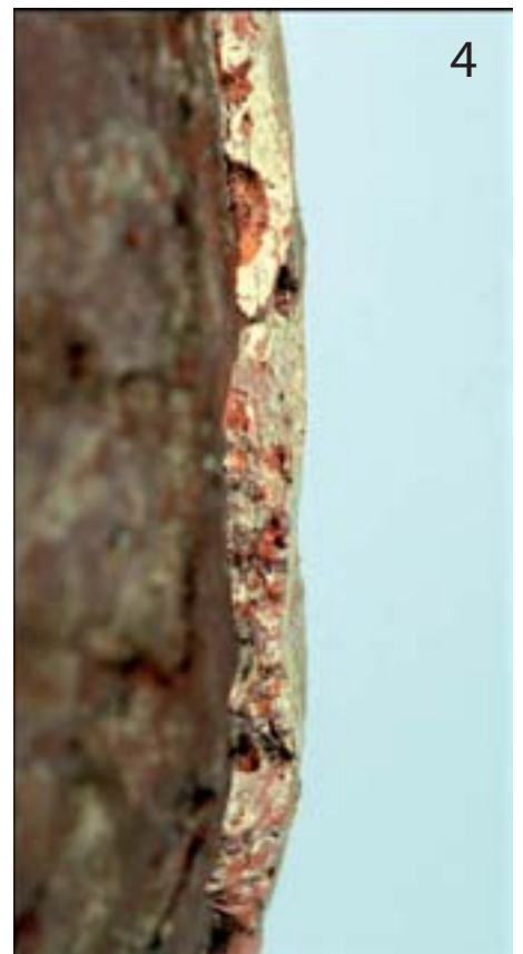
Grietas y fracturas transversales que muestran la colocación de los colombinos en el cuerpo
