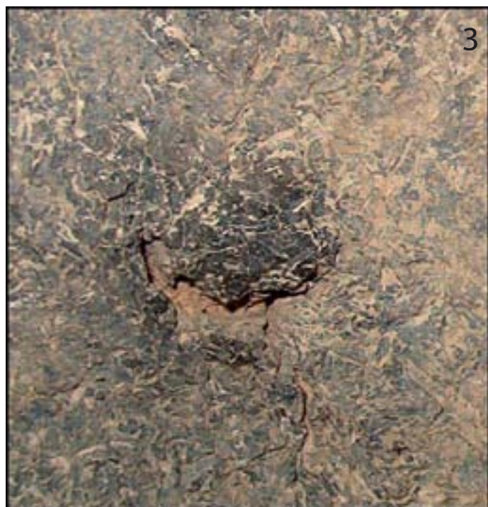
Grieta circular formada debido a la inserción de un extremo del asa
