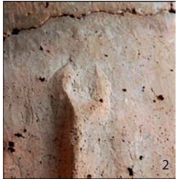
Rebabas asociadas al ensamblaje por arrastrado
