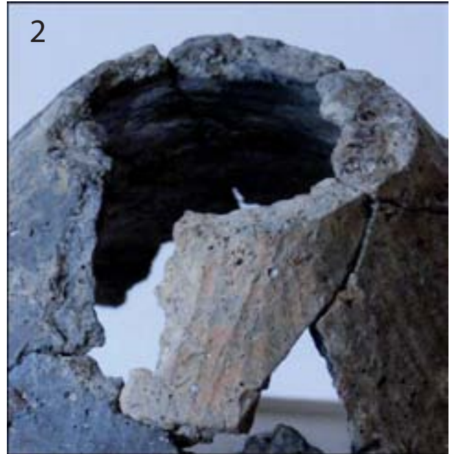
Acanaladuras generadas durante el compactado
