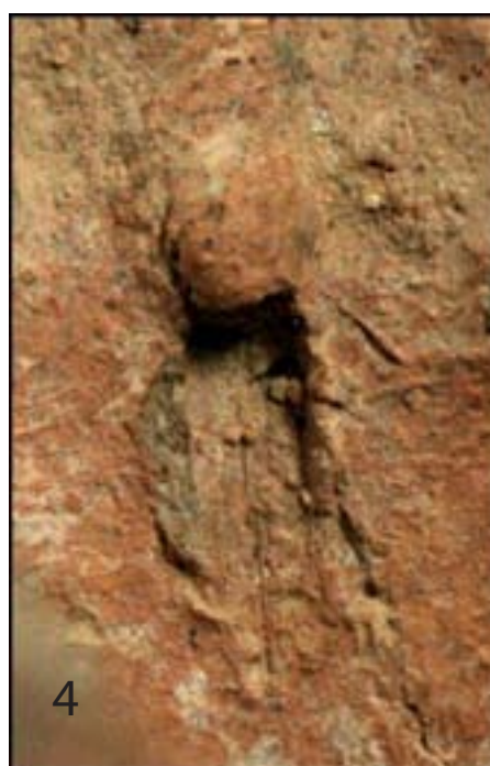
Acanaladuras rayadas que indican compactado y raspado
