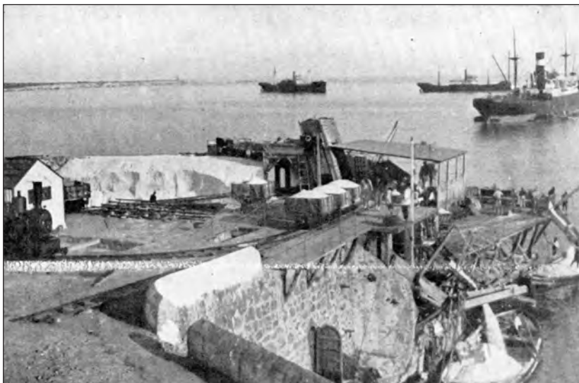
Fot. 1 .-El embarcadero de la Canal. A la izquierda, el depósito de la sal ya molturada ( Plaça de la Sal ). Las vagonetas transportan el producto de los salers al embarcadero. Esta sal será triturada al echarse en las barcazas, que la llevaran hasta el costado de los buques. La mayoría de los barcos suelen ser extranjeros. Conducen la sal, singularmente, hacia los puertos del norte del Atlántico (Islandia, islas Fär Oer, Noruega. Finlandia, Escocia, etc.), donde se destina a la salazón del pescado. Desde la última contienda mundial ha adquirido importancia la demanda de nuestro producto por parte del litoral gallego y del Cantábrico. (Fot.Viñets.)
