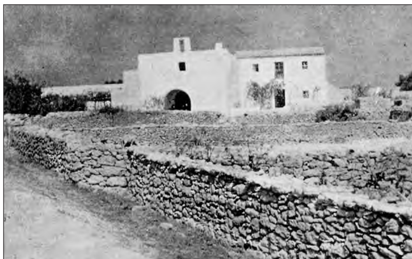
Fig. 2.- La iglesia parroquial de Nuestra. Sra. del Pilar (La Mola) . El edificio, de formas acusadamente simples y geométricas, sigue el tipo de casa ibicenca. Vista obtenida desde la carretera que atraviesa longitudinalmente toda la isla y que desde el embarcadero de La Savina conduce hasta el faro de La Mola.
