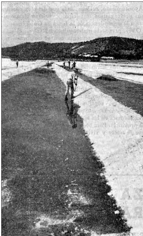
Fig. 1. Vista parcial de un estanque cristalizador de Ibiza. Una vez cavada la sal se amontona en alargadas bandas de sección triangular ( calçades ). Así se deja dos o tres días, para que escurra parte del agua
