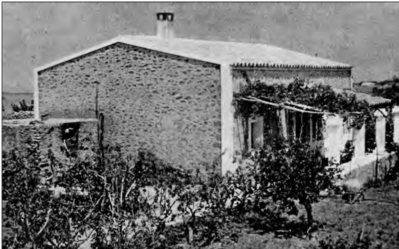
Fig. 2.- La casa de tejas. Can Pep Guillamet (La Mola). Adosada a la fachada, y dando sombra a las aberturas del porxo y la cocina, aparece la larga enramada, cubierta por una parra. Junto a la casa existe un pequeño huerto con vides y algunos árboles frutales, regados mediante agua de la cisterna. En pleno verano, se nos muestra casi agostado.
