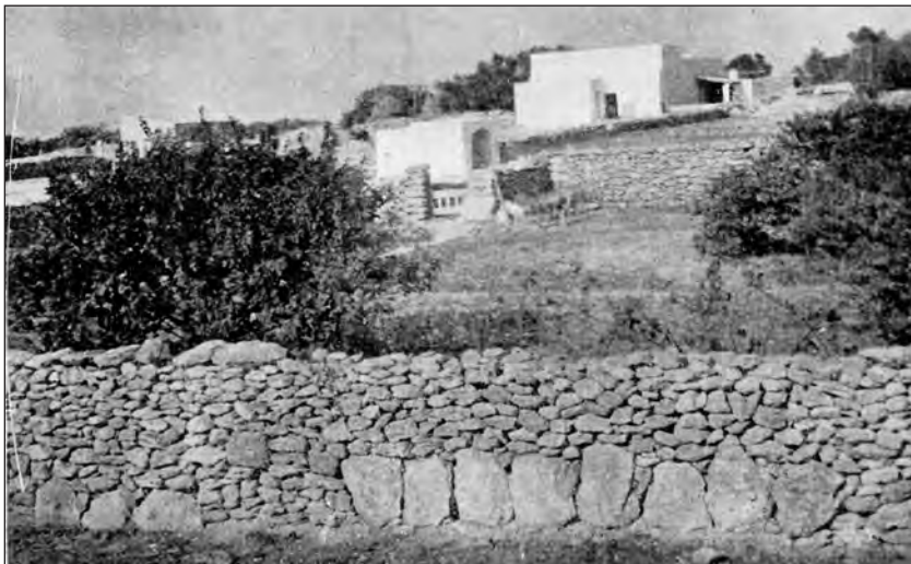
Fig. 2.- La casa de tipo ibicenco evolucionado . Can Talaies en La Mola (véase su planta en la fig. 8). En el centro, la cisterna. Adosado a la casa, un corral. En la fachada, s'enramada , protegiendo del sol la entrada y el horno. A la izquierda de la casa, la era ( s'era ) y la bodega ( sa casa des vi ). Paredes de piedra seca, cuidadosamente ejecutadas, separan los campos y las distintas fincas ( ses hisendes ). Vides y algarrobos aislados. En primer término, detalle de una tanca , hecha de piedra seca. En último término, un rodal de pinos.
