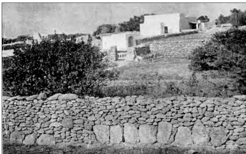
Fig. 2.- La casa de tipo ibicenco evolucionado . Can Talaies en La Mola (véase su planta en la fig. 8). En el centro, la cisterna. Adosado a la casa, un corral. En la fachada, s'enramada , protegiendo del sol la entrada y el horno. A la izquierda de la casa, la era ( s'era ) y la bodega ( sa casa des vi ). Paredes de piedra seca, cuidadosamente ejecutadas, separan los campos y las distintas fincas ( ses hisendes ). Vides y algarrobos aislados. En primer término, detalle de una tanca, hecha de piedra seca. En último término, un rodal de pinos.
