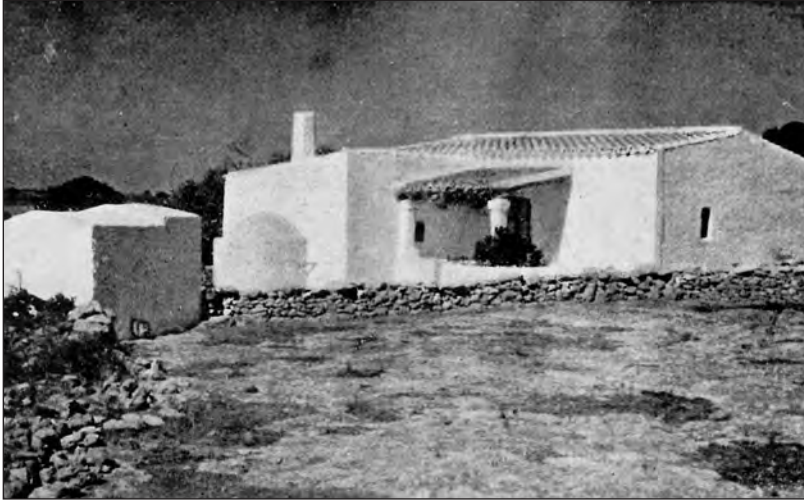
Fig. 1.- La casa de tejas. Can Joanet Iern (Sant Francesc Xavier. Véase su planta en la fig. 9.) . A la izquierda, la cisterna. Adosada a la fachada, la cocina con el horno del pan, y protegiendo la puerta s'enramada . Paredes cuidadosamente encaladas. Vanos reducidos. Tejado de pendiente suave. La casa está asentada sobre una costra caliza, en espacio inaprovechable. Detrás de la casa, nopales y algunos árboles frutales y pinos. No se ven los corrales.
