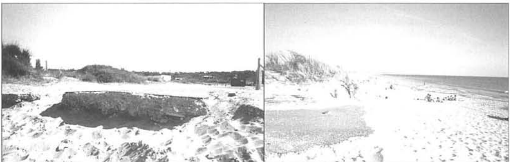
Figura 6. Carretera cortada por la erosión en la playa de Vertbois (costa oeste de la Isla de Olerón).
