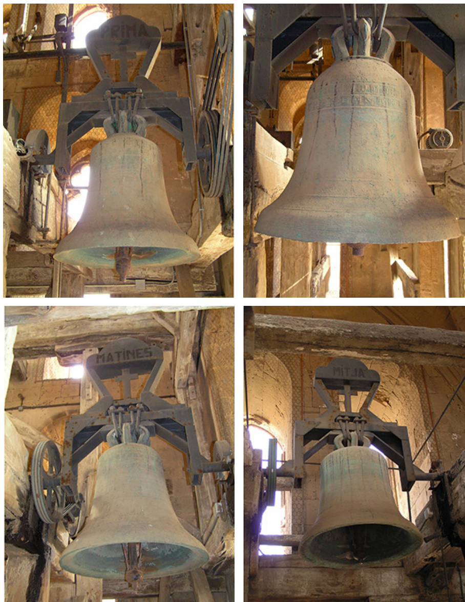
Fig. 16. Conjunt de campanes de 1312, Seu de Mallorca: Na Prima, Na Picarol, Na Matines, Na Mitja. Actualment amb jous de ferro i tocs mecanitzats que n'alteren el so; recentment els jous s'han repintat i la pintura ha regalimat damunt les campanes (fotos Francesc Llop i Bayo).
