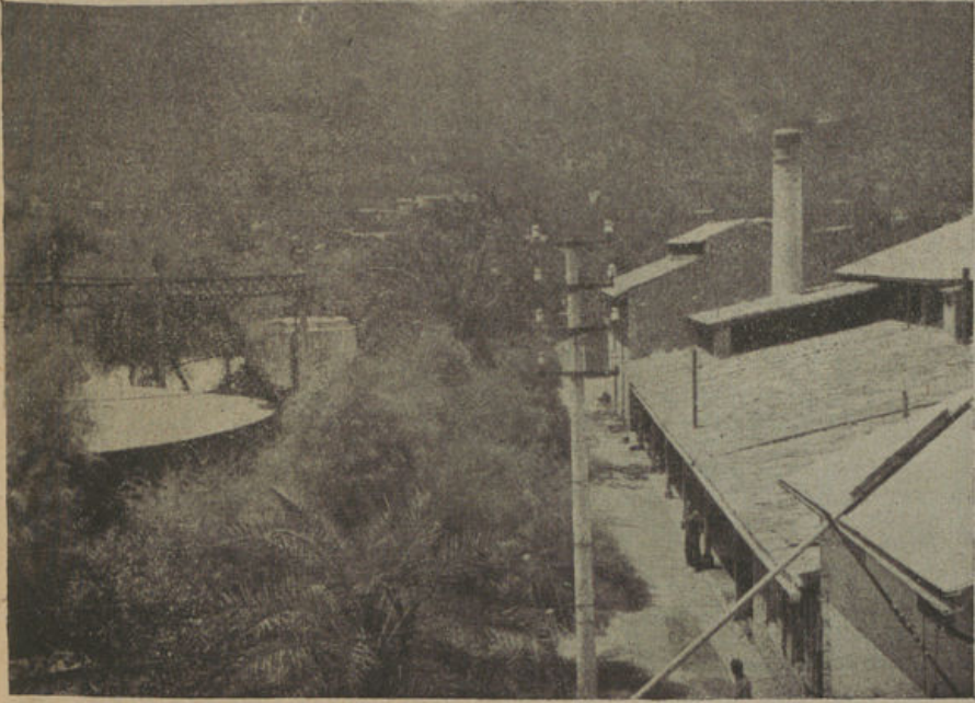
Aspecto exterior de la fábrica de gas
