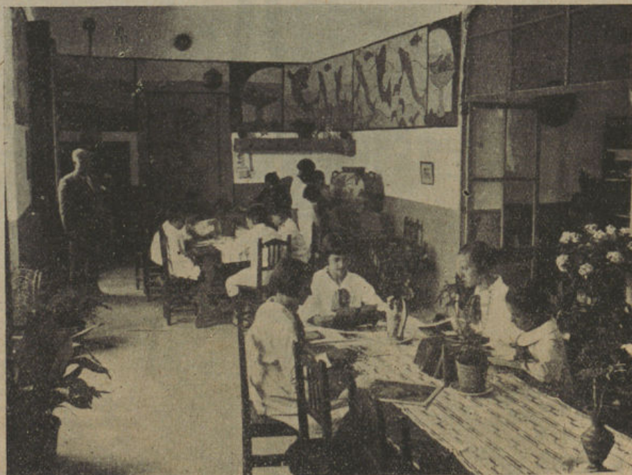
Salón de recreo y lectura del edificio de la Cantina
