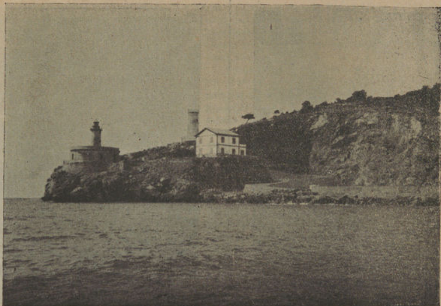
Vista de conjunto del desmonte efectuado en la entrada del Puerto para extraer materiales con destino al nuevo muelle
