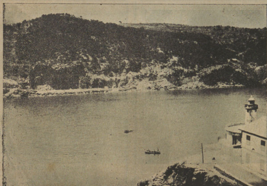
Estado en que se encuentra la playa artificial que se construye entre el Cap de sa Paret y el Recó de s'Argentera
