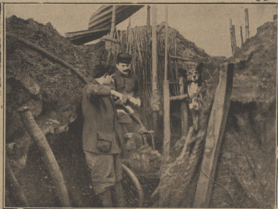
MOSA.—Bomba aspirante manejada por suavos y destinada á desecar las trincheras y quitar el barro.
