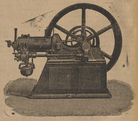
Única casa constructora de los legitimos motores "OTTO, para gas de alumbrado.
