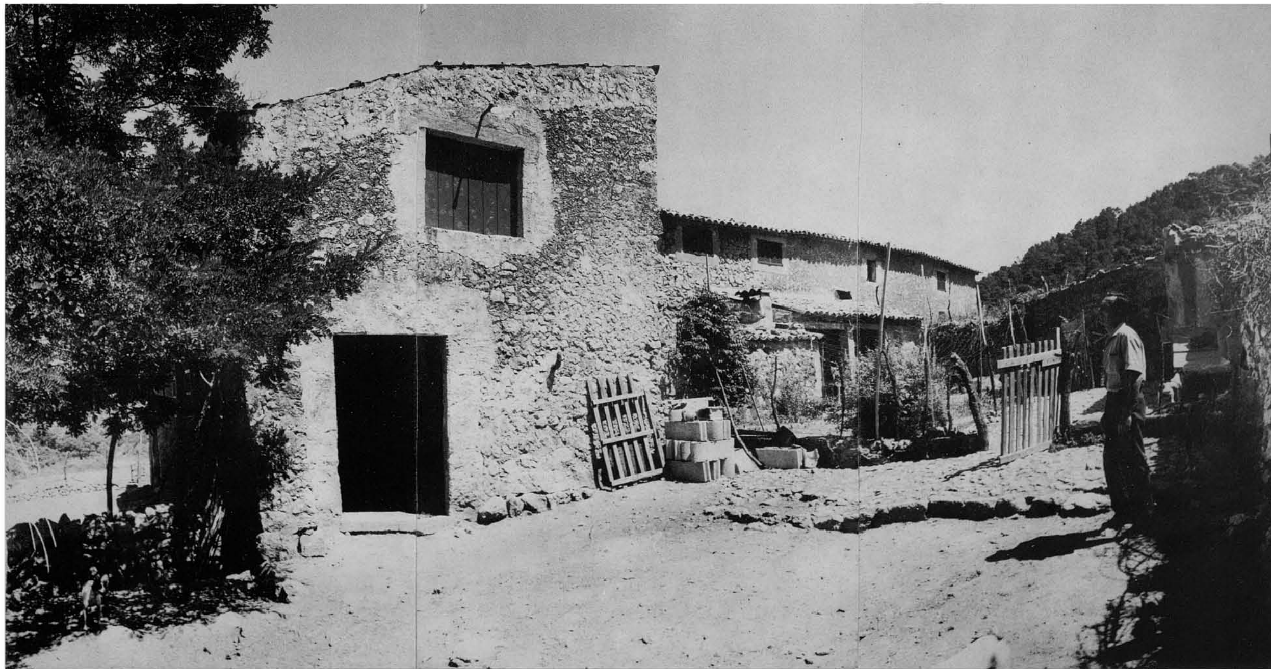
17. Interior de la clastra i façana de les cases pageses de Binifaldó, posterior a la de la foto anterior. Per aquesta banda les cases conserven el seu aspecte rústic més antic.
