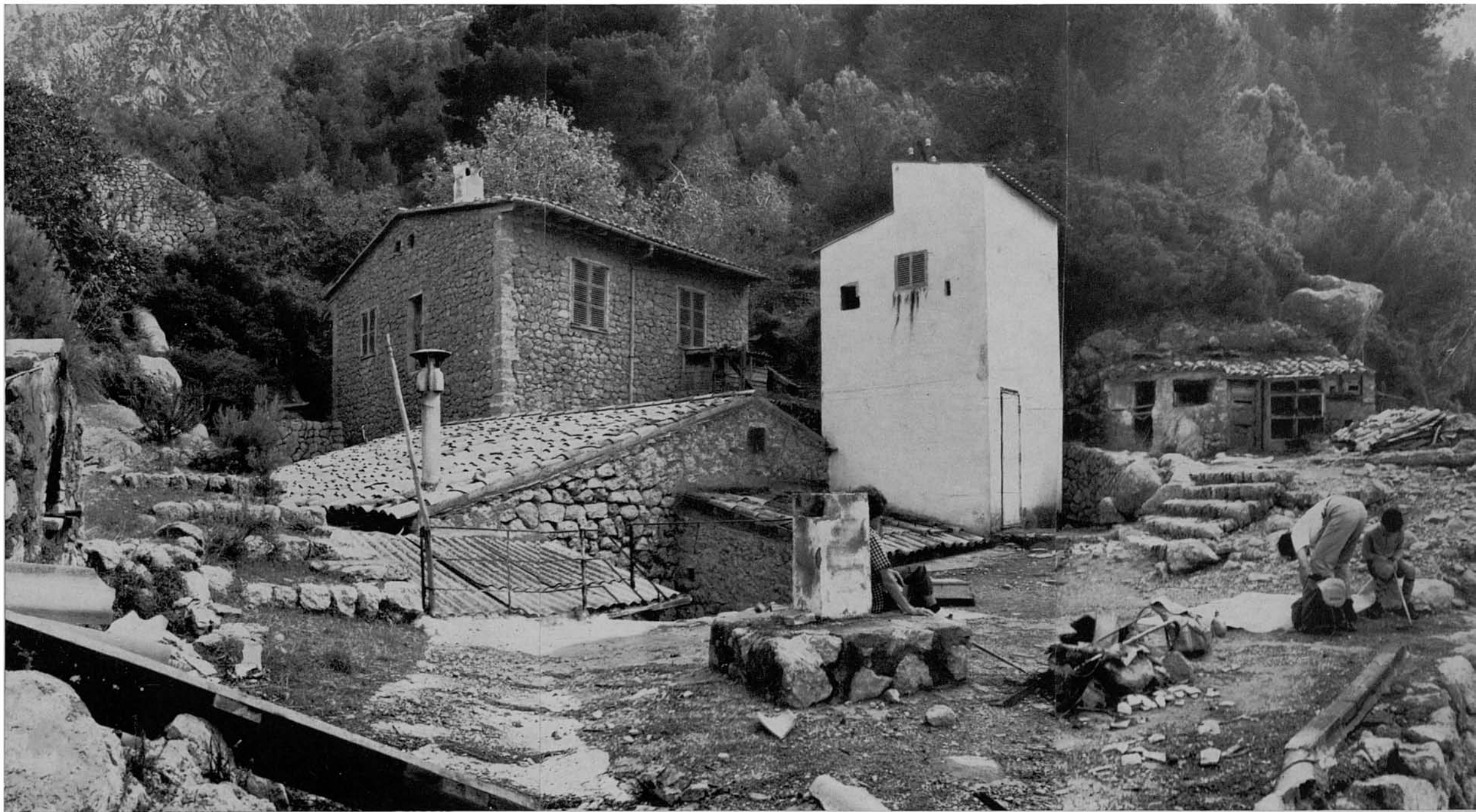
117. Una mica més avall s'hi troben les pròpies instal·lacions de la centraleta, l'exterior de la qual s'hi veu ací, i...
