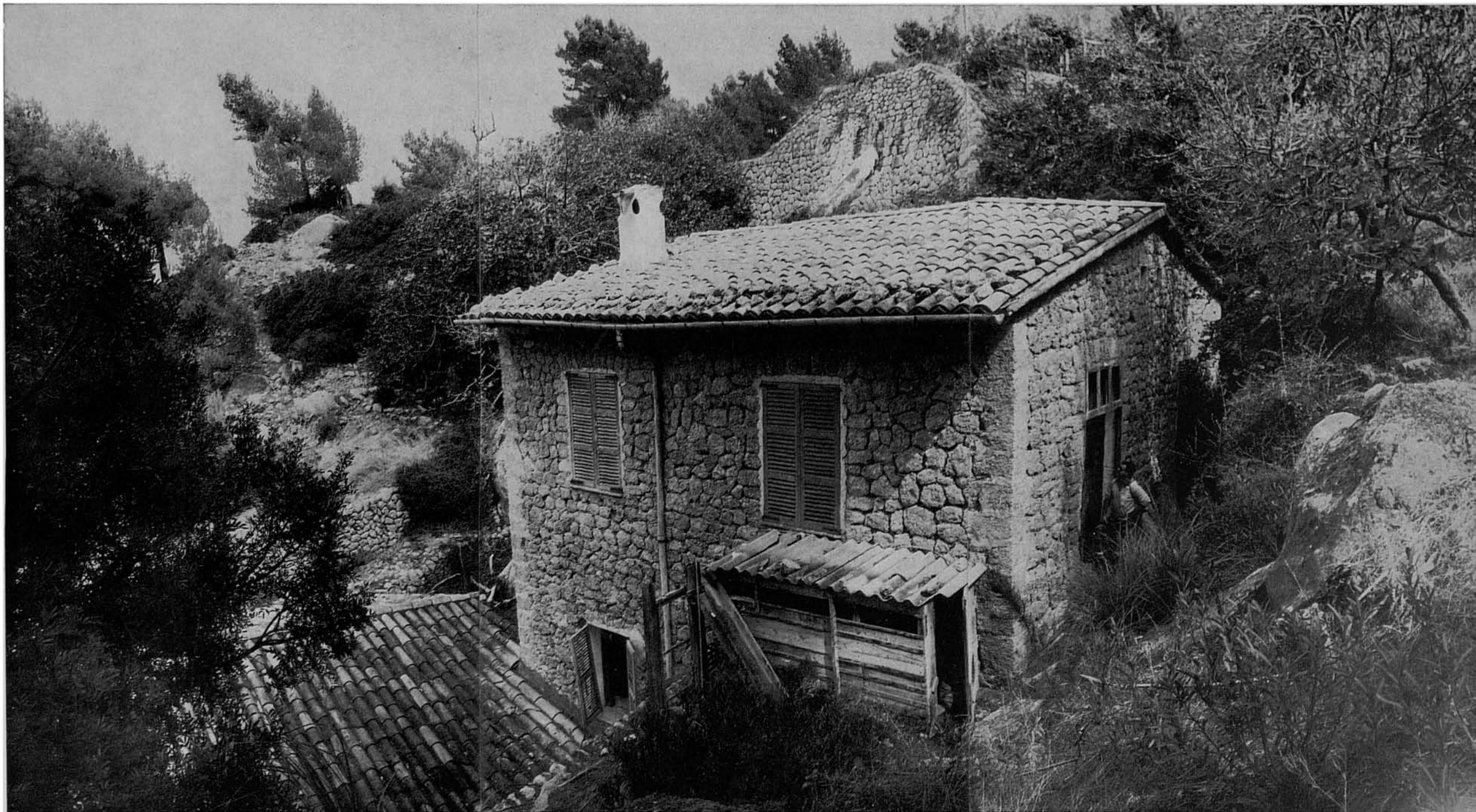
116. ...l'edificació de la vivenda de la família que tenia a cura la Centraleta. Aquestes cases s'hi troben, naturalment, abandonades i començada la seva ruïna. Tot i aixó, com a prova de que no fa tantíssims anys que encara estaven habitades, y la centraleta en funcions, —es va aturar a l'any 1962— encara s'hi veuen —buits igualment— els galliners i conilleres que el temps encara no ha desfet. També hi resten allà figueres i nispers, tots de dolcíssim fruit —en donam fe—, fruits que, cadascú al seu temps, cauen de madurs i es perden sense que ningú s'ocupi d'ells.
