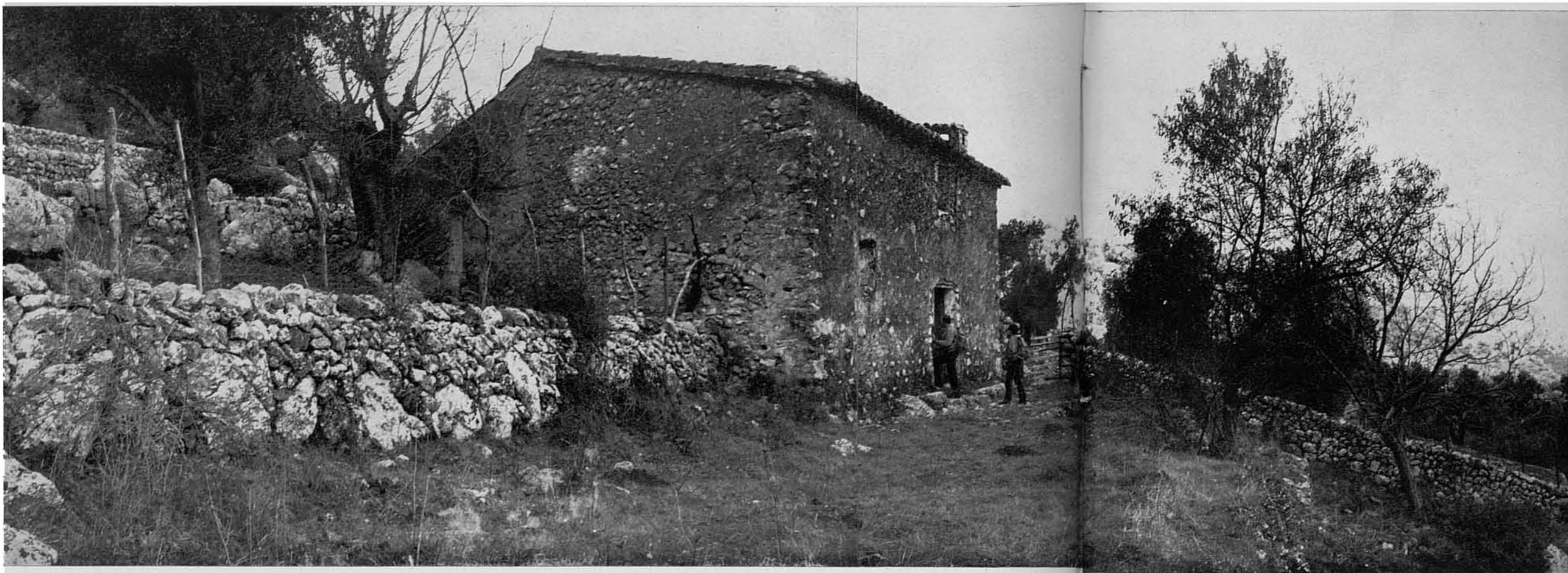
14. Ja prop de la fondalada de Montcaire, el camí passa pel costat d'aquesta vella i rústica edificació. Es Ca'n Codony, casa ara deshabitada, abandonada i mig ruïnosa, que no fa tant de temps coneguerem ocupada.
