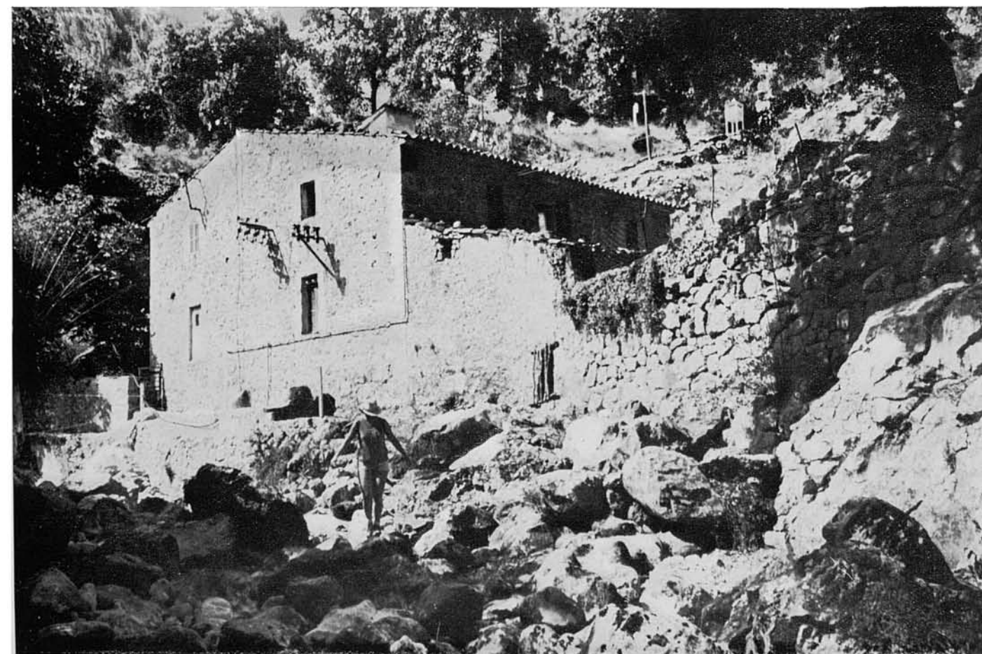
56-57. L'edificació, a fi d'aprofitar el màxim desnivell per el salt es troba vora mateix del torrent, en lloc ja molt aspre i abrupte, encara que des d'allà, el torrent va adquirint major feresa, fins a fer impossible el seu recorregut pel fons, del qual s'ha de sortir per seguir endavant, en alguna ocasió.
