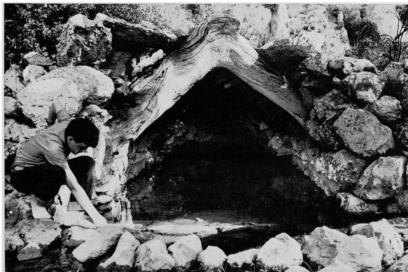
56-57. Ens dirigim primer al pla de les basses per a refrescar-nos i descarregar la impedimenta, car és aquí on farem la pausa pel dinar. Aquesta bassa està coberta amb volta de pedres bastant grosses sobre una vigueria de troncs d'ullastre. Es notable la peça del frontis, pel seu tamany i adequada forma natural com es pot apreciar millor en la fotografia de la coberta. L'aigua d'aquesta bassa és potable, encara que el bestiar hi té accés. Allà prop, a unes quantes passes, n'hi ha una altra en forma de pouet, que és de més confiança.
