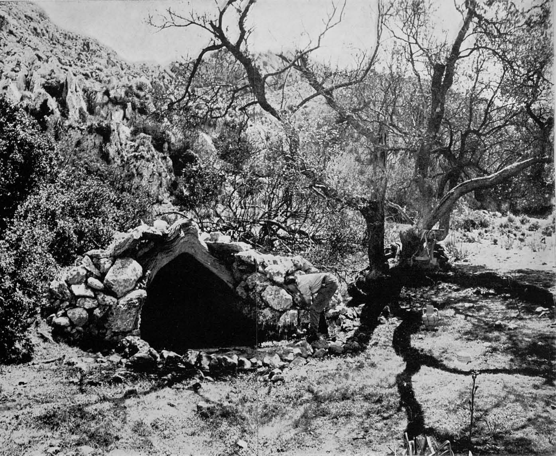
56-57. Ens dirigim primer al pla de les basses per a refrescar-nos i descarregar la impedimenta, car és aquí on farem la pausa pel dinar. Aquesta bassa està coberta amb volta de pedres bastant grosses sobre una vigueria de troncs d'ullastre. Es notable la peça del frontis, pel seu tamany i adequada forma natural com es pot apreciar millor en la fotografia de la coberta. L'aigua d'aquesta bassa és potable, encara que el bestiar hi té accés. Allà prop, a unes quantes passes, n'hi ha una altra en forma de pouet, que és de més confiança.
