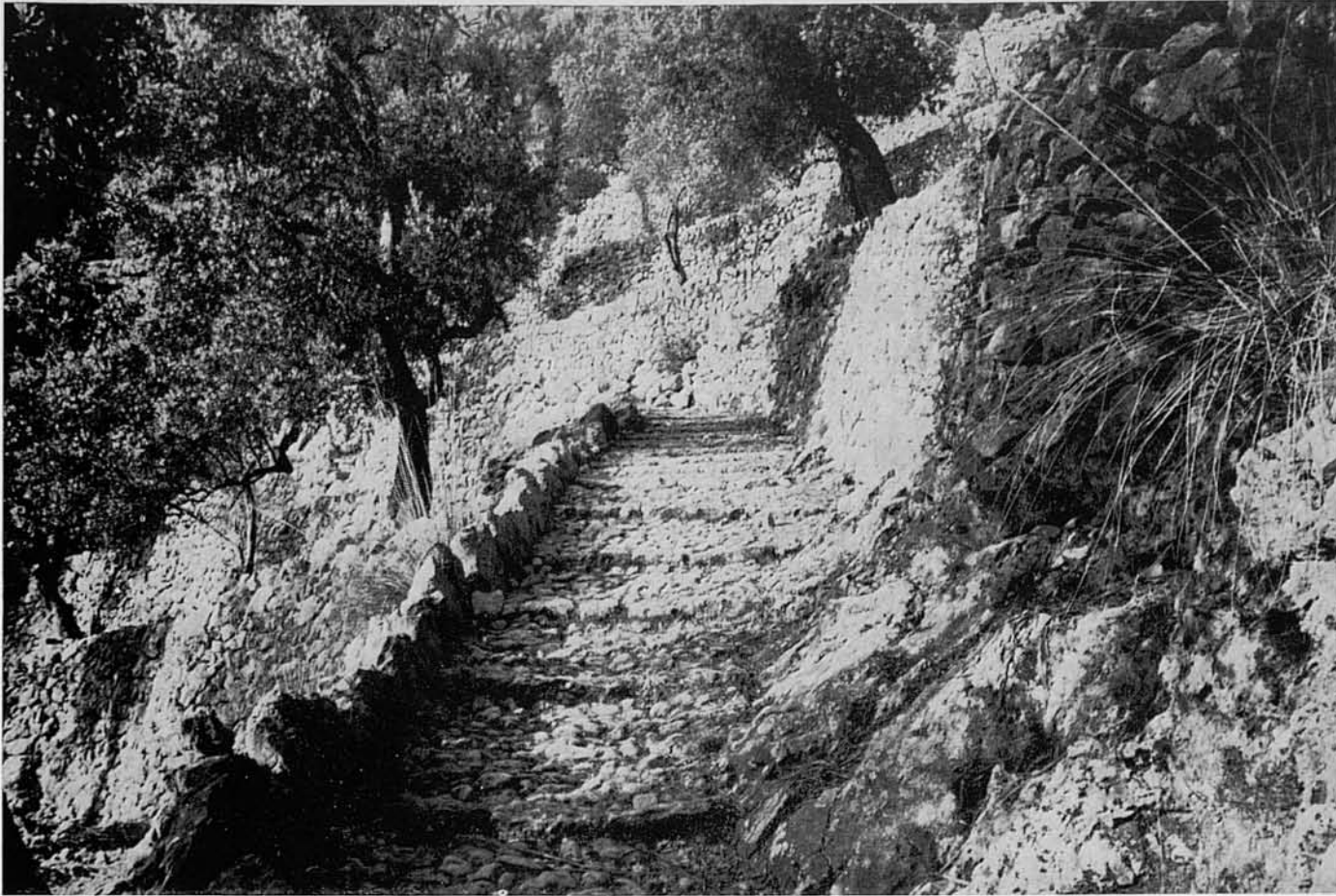
40. ...sempre marginat per una filera de grossos còdols i de les parets que sostenen arreu innumera- bles marges de conradís, contenint l'esllavissada dels costers.
