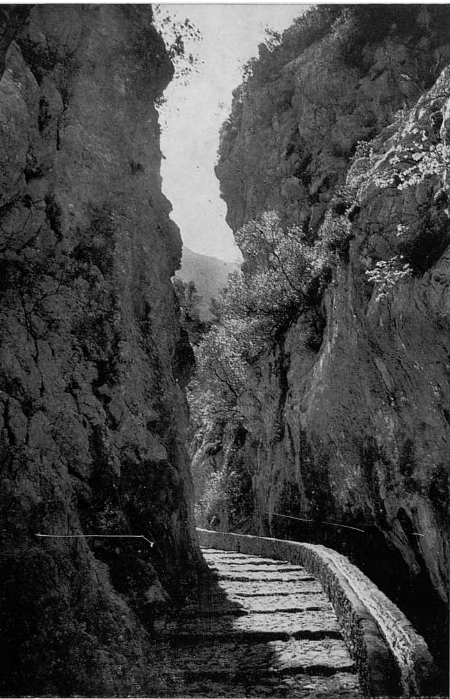
27. Aquí és on es troba la major estretor, en un paisatge d'excipional brabesa. Pel costat del camí, al llarg del mur de contenció, una canaleta de teules du cap a Biniraix l'aigua d'una font.
