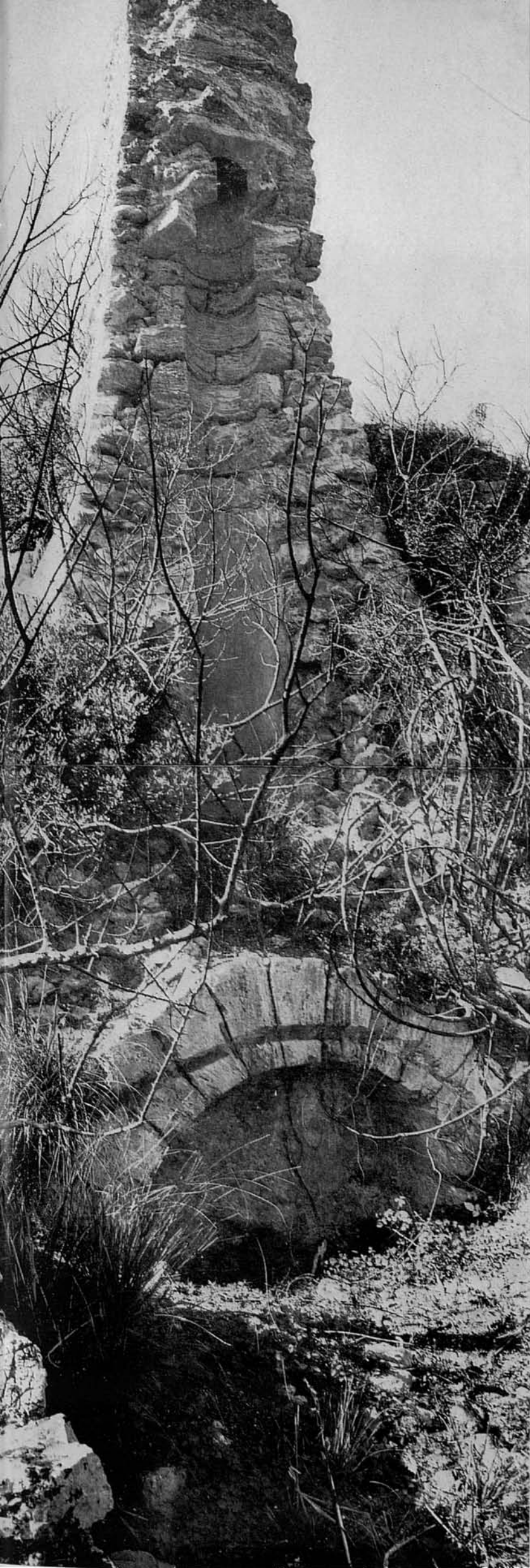
81. En aquest barranc, a mitja altura, hi ha les ruïnes d'un vell molí d'aigua, del qual encara es conserva en peu una paret de l'aqüeducte, rematat per un canó que té incrustat en salt vertical,
