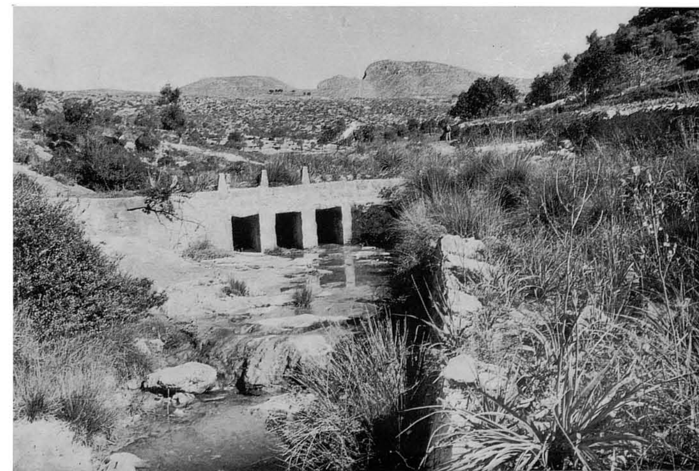
21. El camí particular d'accés a Son Morei Vell travessa aquí el torrent per un pontarró fet d'ha poc i segueix pujant fins a les cases.
