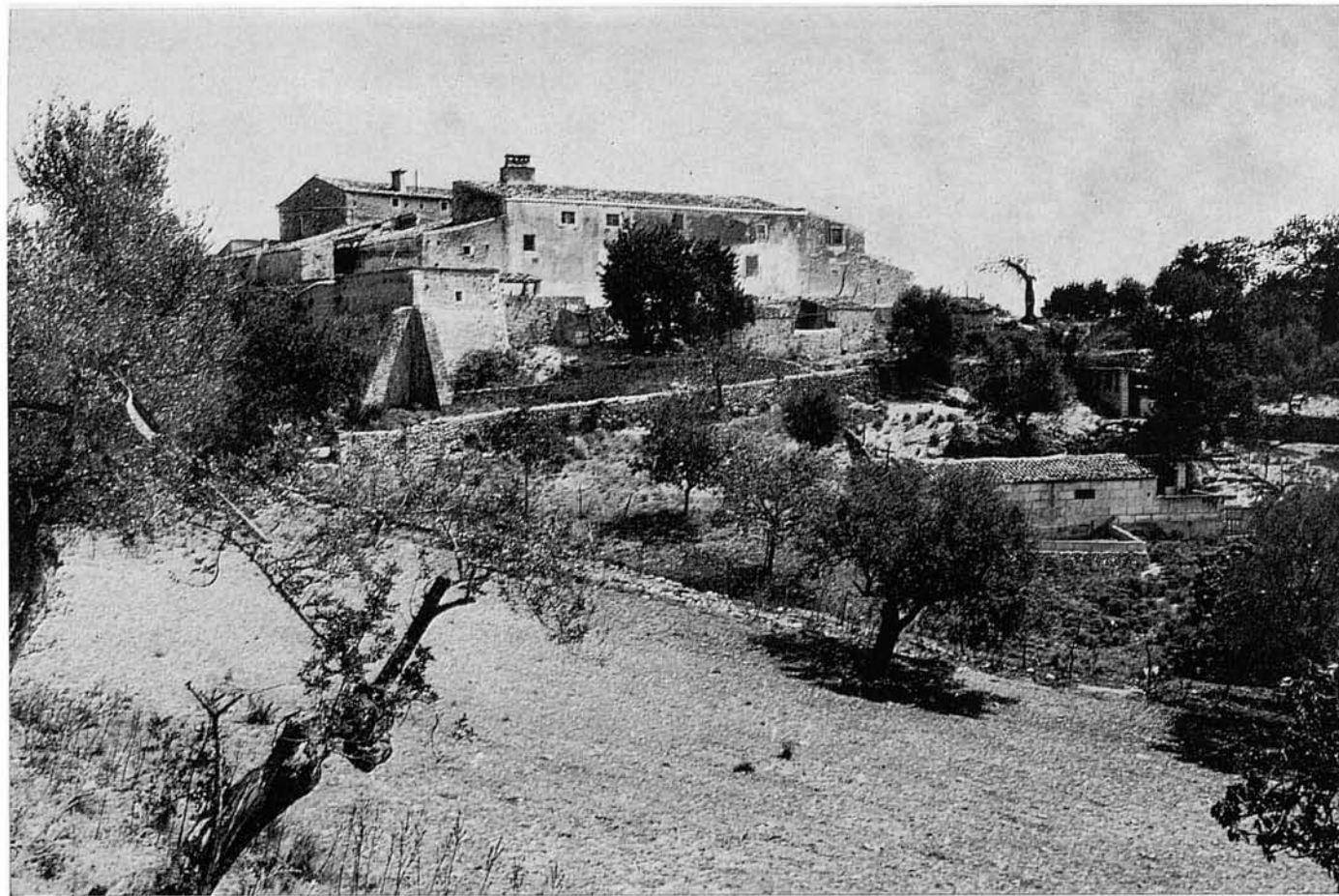
64. Presa la seva vista des de més lluny, aquest és l'aspecte de l'edificació de Santiani Vell,...
