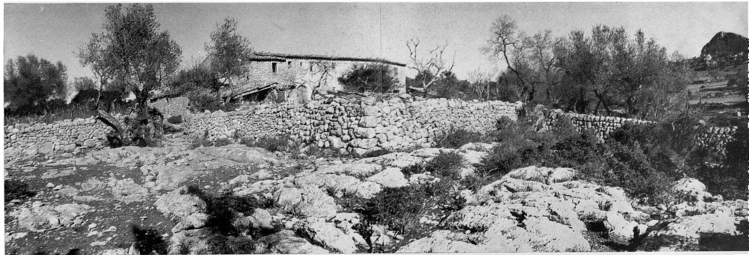
30. La casa està defensada a més per un altre recinte exterior, que la separa dels terrenys de cultiu. A l'extrema dreta compareix la Cuculla de Fartàritx amb la seva aguda punta a 700 m.
