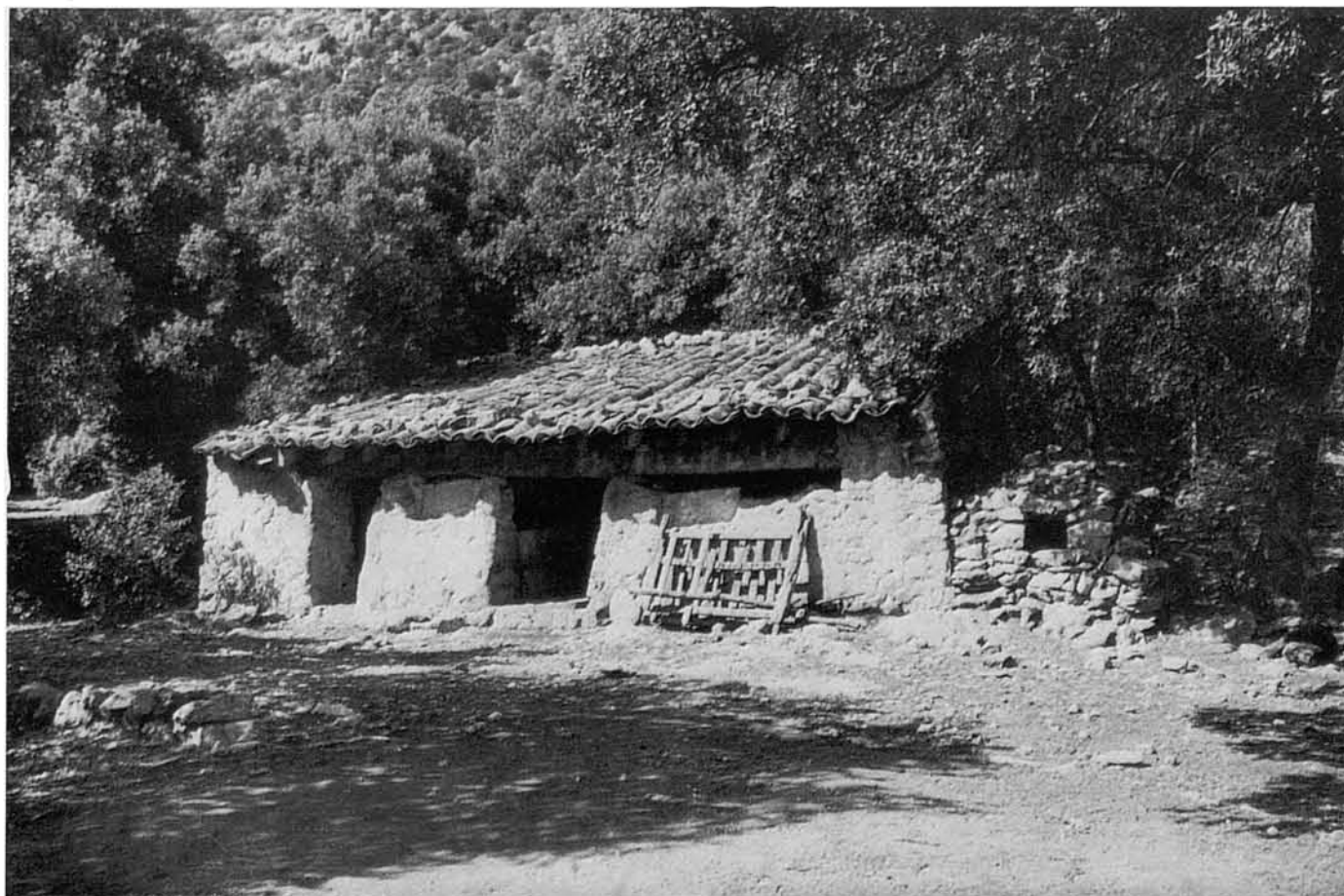
78. ...passa per devora un porxo —ara convertit en estable refugi pel bestiar a lloure—, que altre temps pot haver estat barraca permanent de carboners i depòsit de carbó, amb un forn de coure pa anexe i l'espaiosa sitja al davant...
