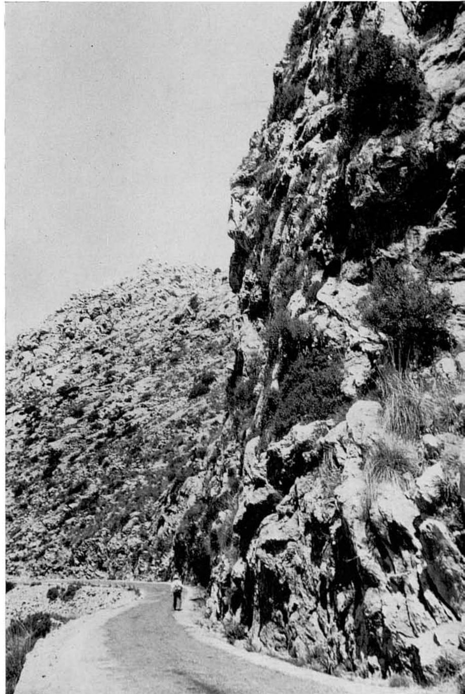
76. Alguns trossos de la carretera van sostenguts per altes parets artificials sobre el pendís del coster...
