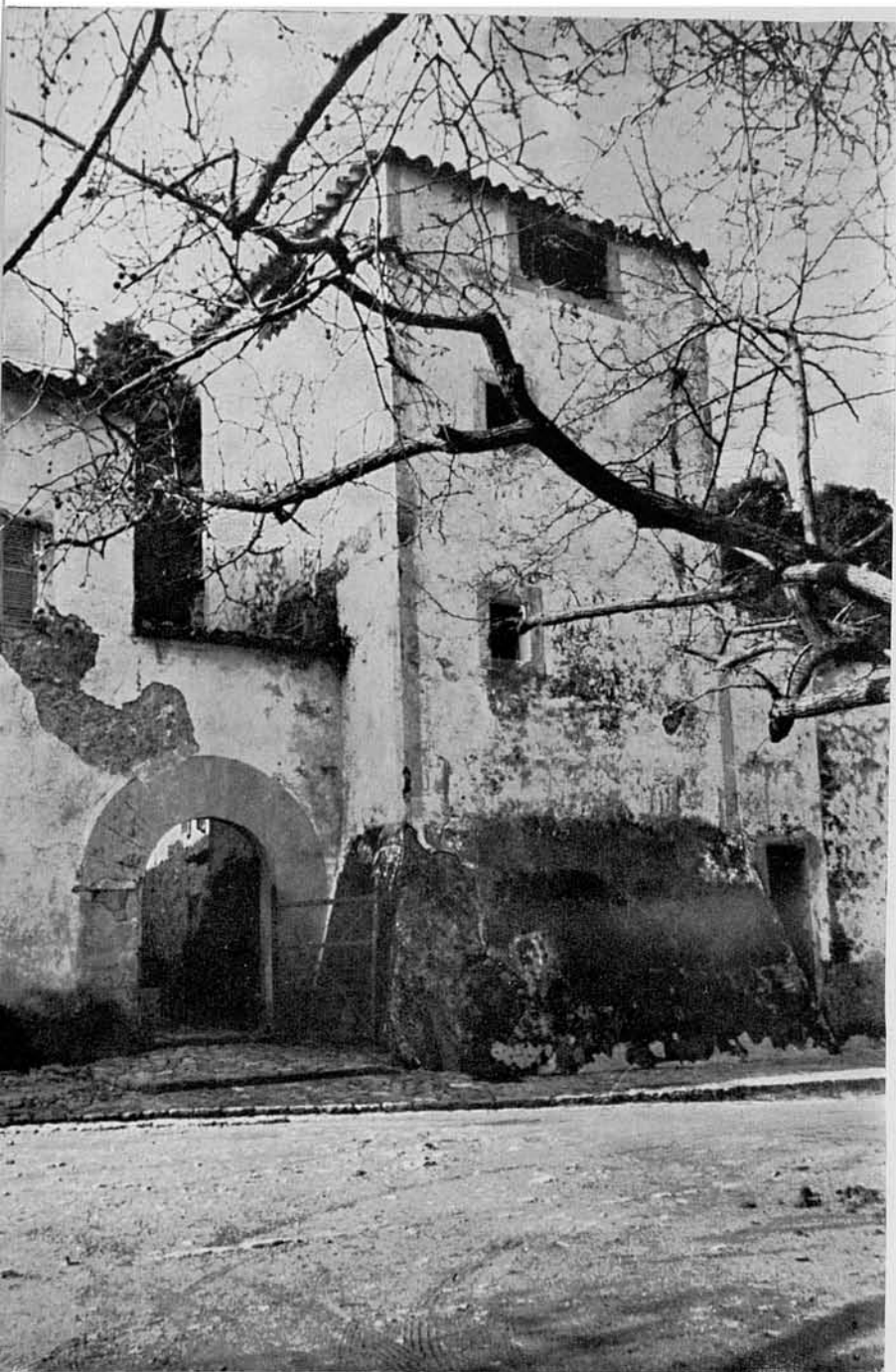
79. El portal forà està defensat per una robusta torre, com últim reducte contra les incursions de pirates i correrries de bandolers. Les parets de l'edificació son molt gruixades, i superen en moltes parts el metre d'amplària.
