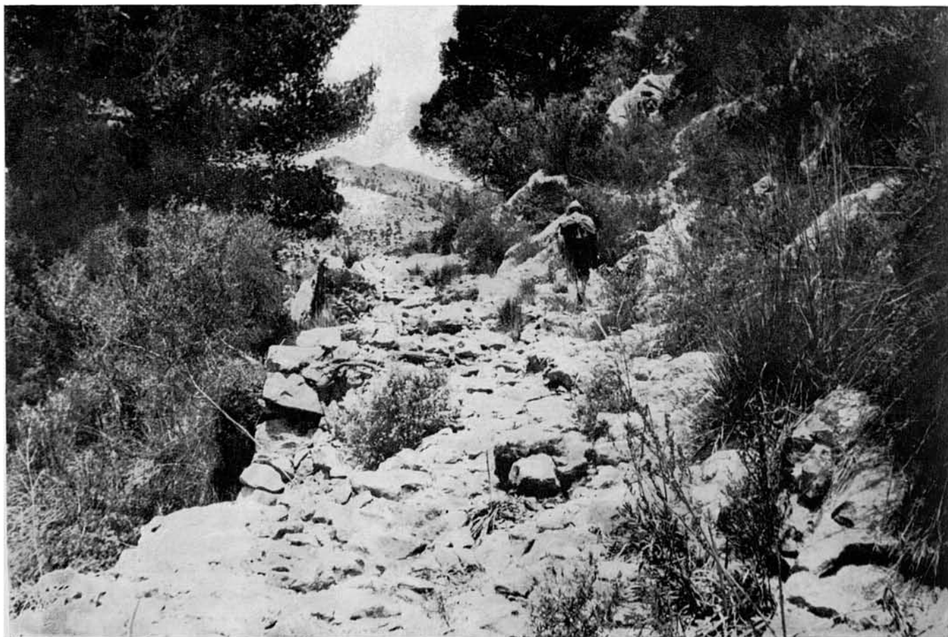
18. En molts indrets està totalment desfet i resulta incòmode per la descarnadura i movilitat del que fou un dia l'empedrat.
