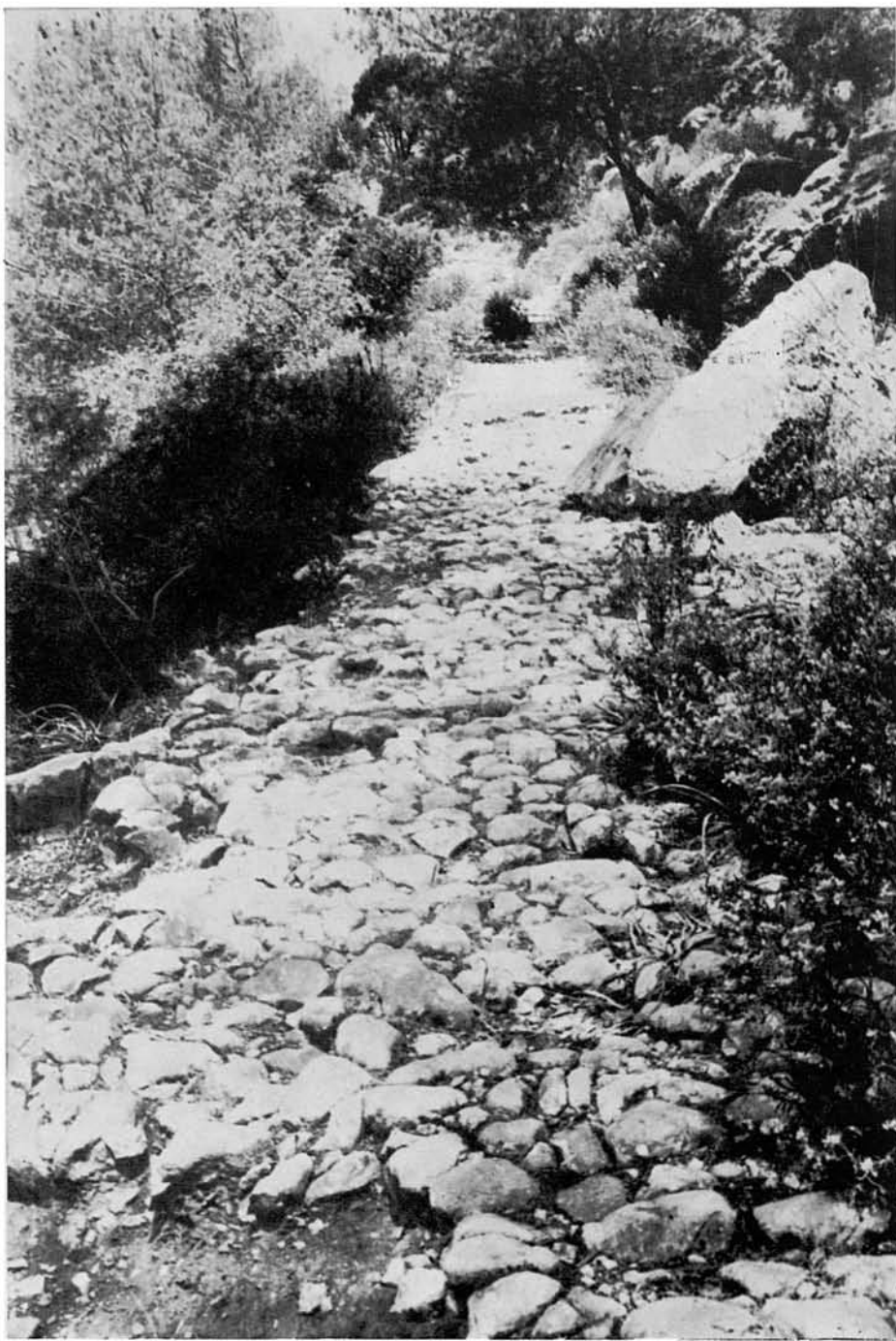
17. L'amplària i disposició de l'empedrat, així com la forma i desnivell d'alguns revolts delaten que es tractava d'un camí de ferradura, impracticable pels carros.
