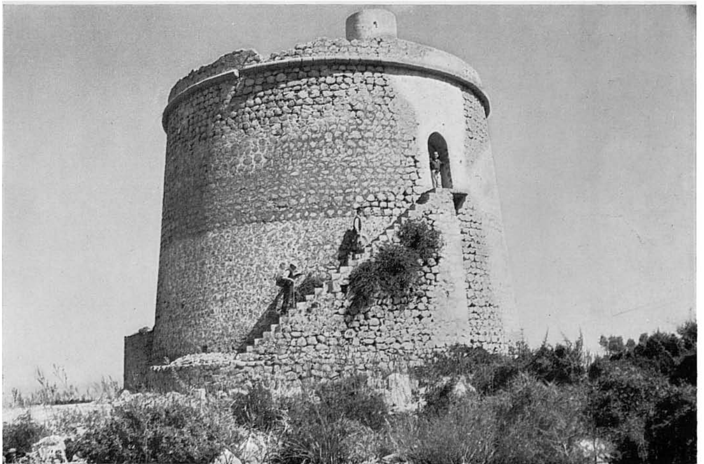
6. Pujam a la torre. Una escala exterior dóna accés al que foren habitacions del governador, i des d'allà, per una altra escala interior de caragol, es munta a la plataforma superior...
