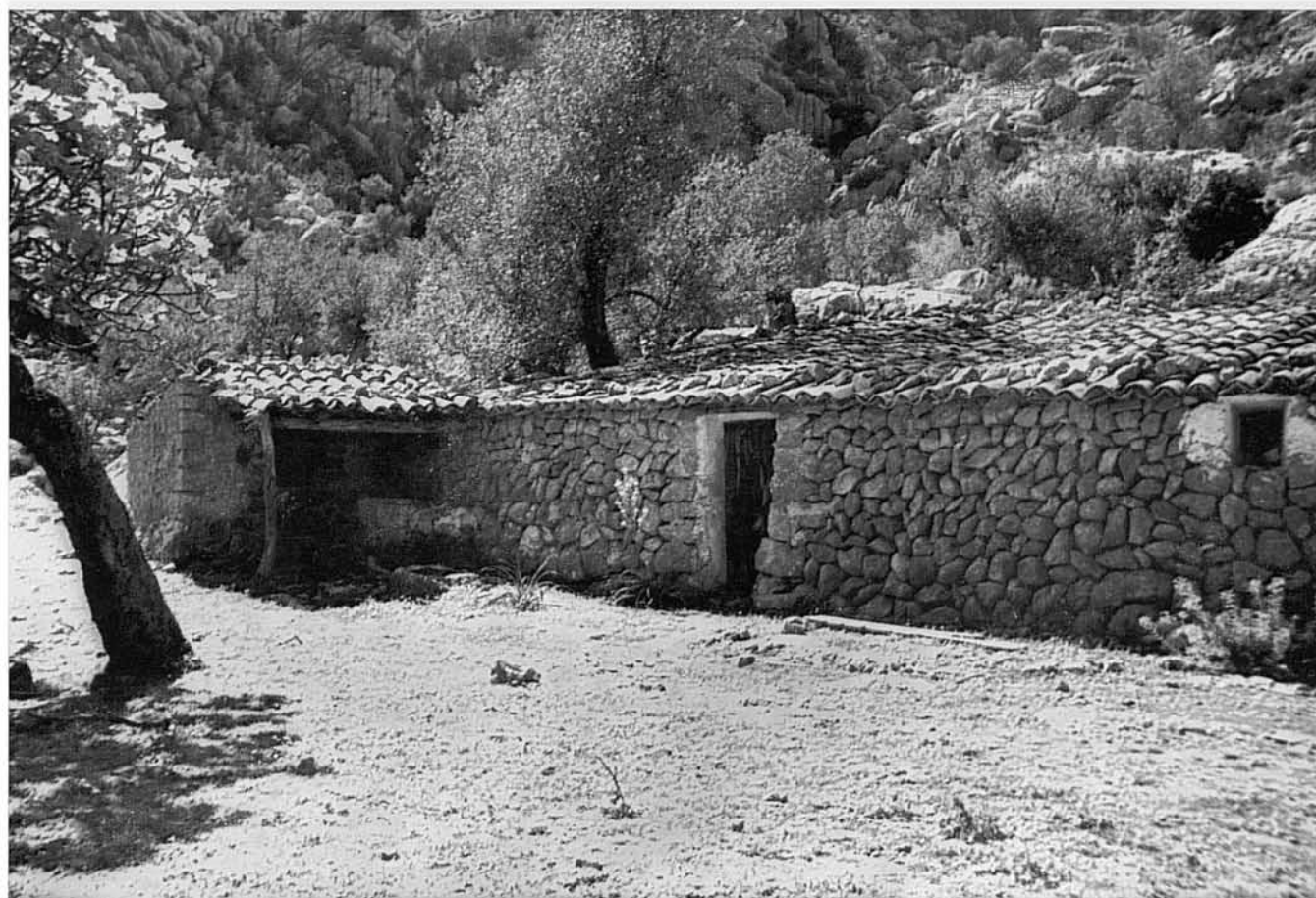
58. ... i la casa de la Tanca en un lloc agrest i de singular bellesa, que convida al merescut descans i refrigeri.
