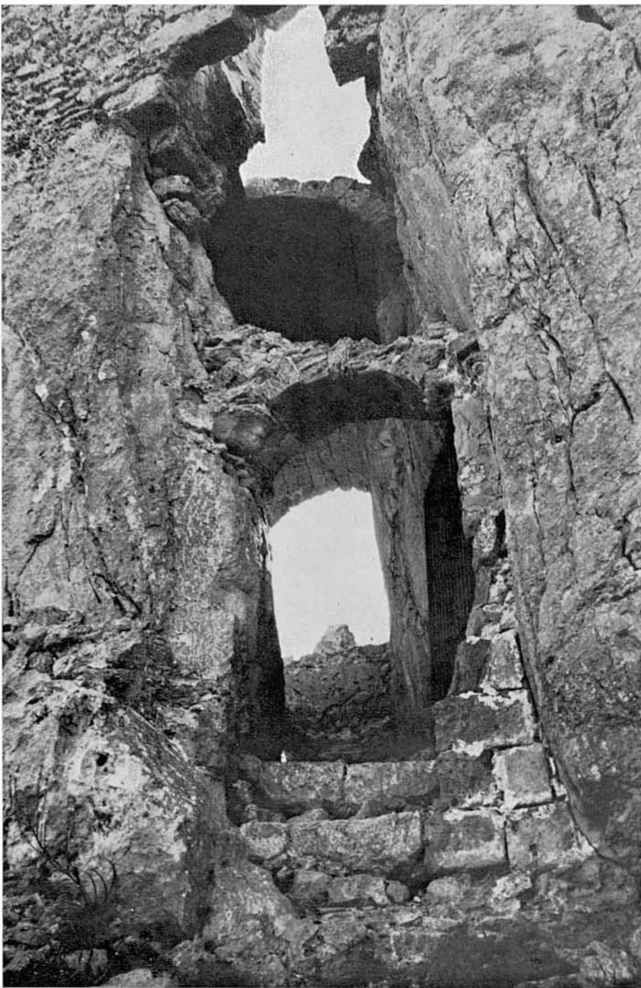
L'entrada del castell s'obri aprofitant una esqueixa de la roca, a on queden encara restes d'arcs i de voltes cobrint un estret corredor en rampa, que torç a l'esquerra...
