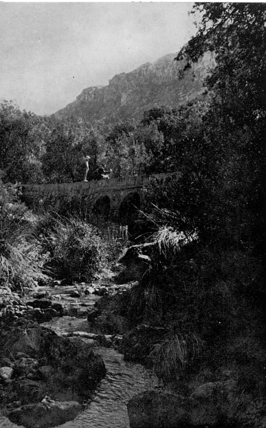
A penes emprès, aquest camí, modern, salva el torrent per un modest pontarró...
