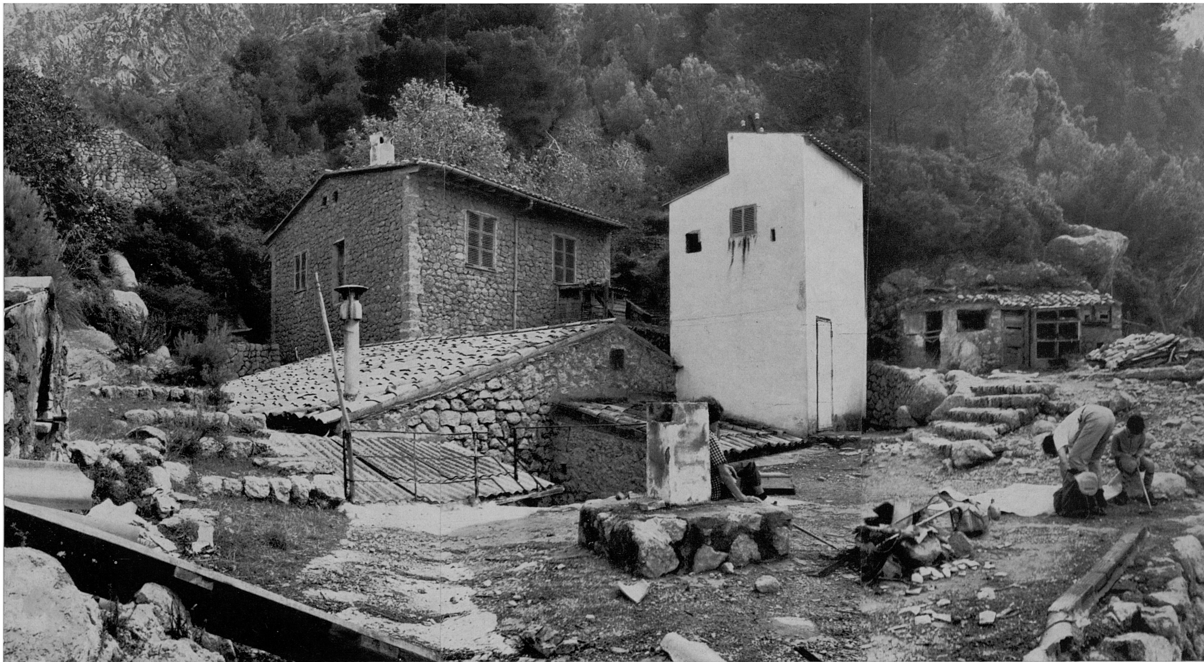
117. Una mica més avall s'hi troben les pròpies instal·lacions de la centraleta, l'exterior de la qual s'hi veu ací, i...
