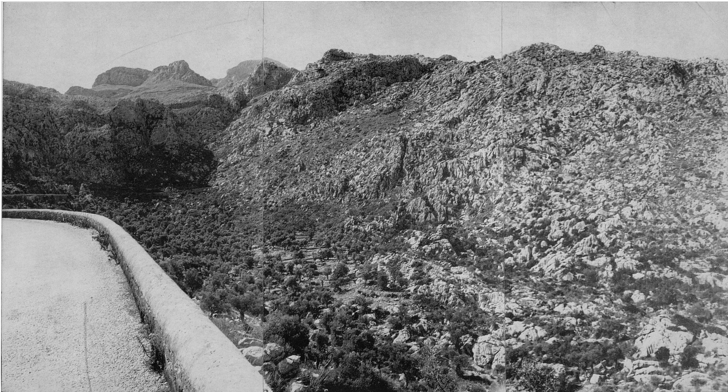
5. ...coma que mostra aquesta fotografia, presa des del dit recolze de la carretera. A la part de dalt d'aquesta coma, de bell nou la carretera es revolta mitjançant un angle agut. Es precisament a aquest punt on s'inicia el Camí de la Barra, que puja a continuació pel coster que es veu enfront, dreta, aprofitant la seva part que apareix més practicable i suau, coberta de càrritx, a la part d'ací de la cella rocosa del centre dalt, en ombra.
