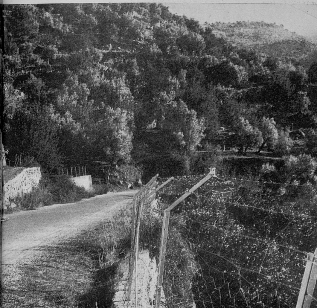
2. ...i, travessada poc més amunt la carretera subsidiària, que comunica el poble amb la de Sóller al Puig Major, anam pujant pel vell camí de Sa Comuna, que segueix a l'altra part de la carretera, com indica aquesta fotografia,...
